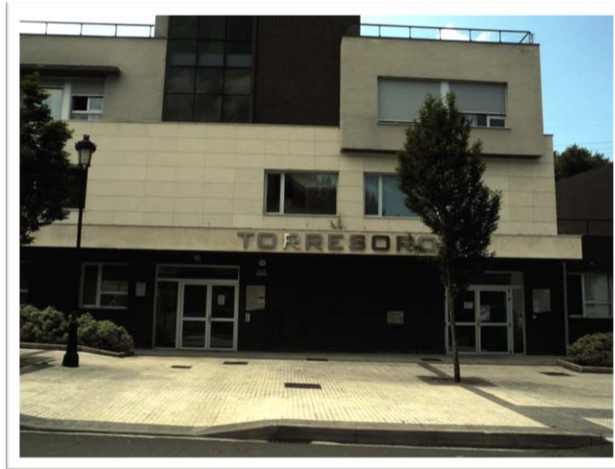
Fachada del centro rural polivalente de Antzuola
