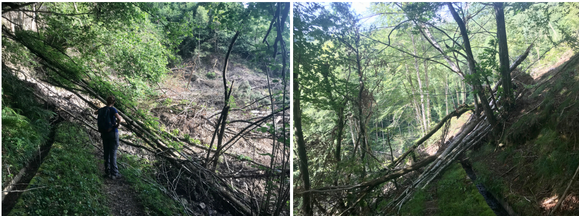
Fotografías desde el tramo no afectado (en forma de isla) del canal de agua (y el sendero alledaño); mirando hacia la lengua principal (izquierda) y hacia el lóbulo lateral (derecha).
