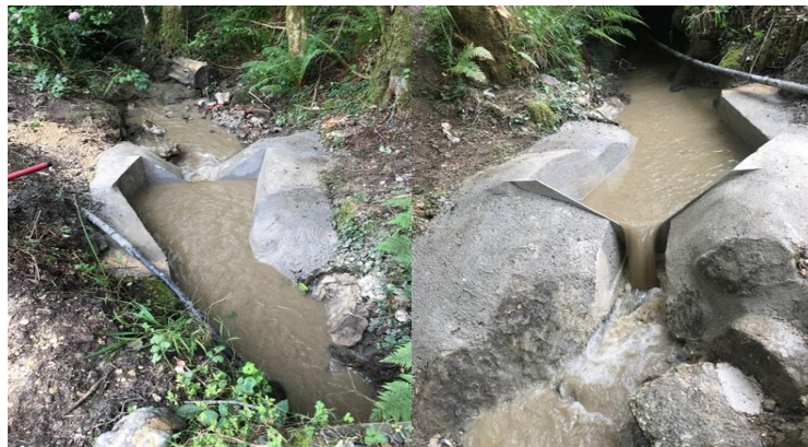
Figura 15: Fotos de la estación de aforo durante la primera fase de instalación, donde se completó la obra de instalación del vertedero y se colocaron la sonda de nivel y la regleta.
