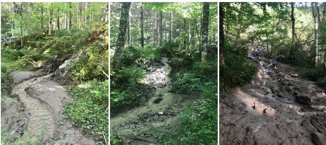
Algunas de las regatas afectadas por el deslizamiento; las primeras dos fotografías (izquierda y centro) muestran la regata que es afectada por el lóbulo lateral, la tercera (derecha) muestra parte del desvío de la regata de Gorospe hacia la pista que asciende desde el túnel del ferrocarril.
