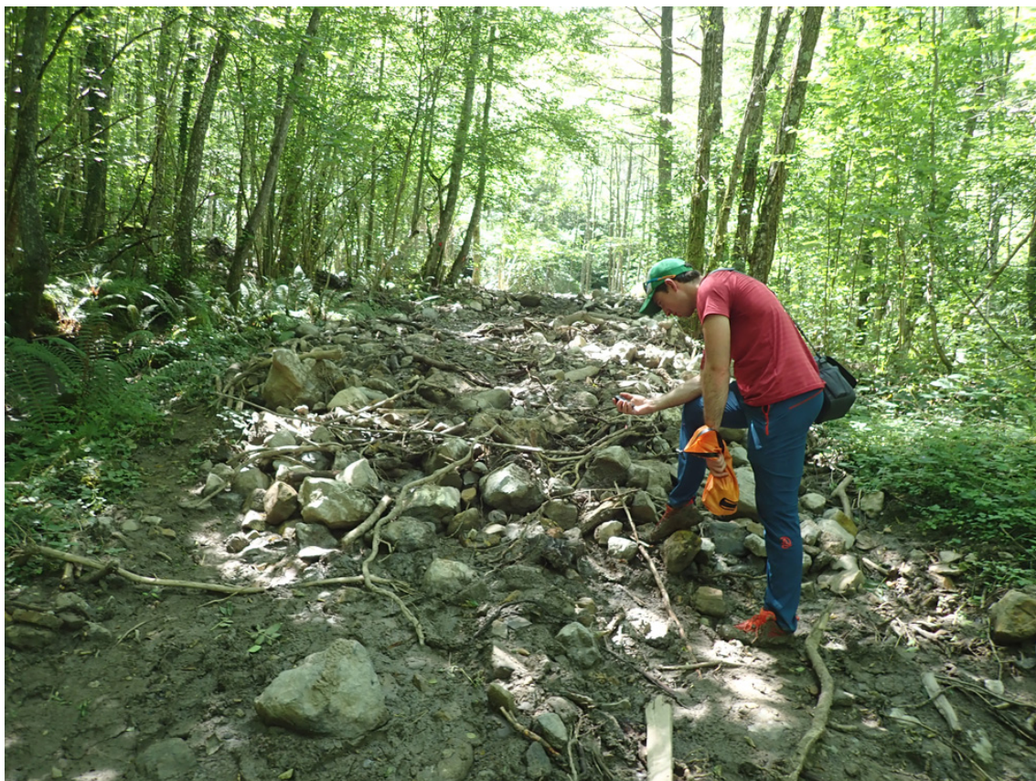
Límite inferior del deslizamiento sobre la pista que sube tras pasar el túnel del ferrocarril.
