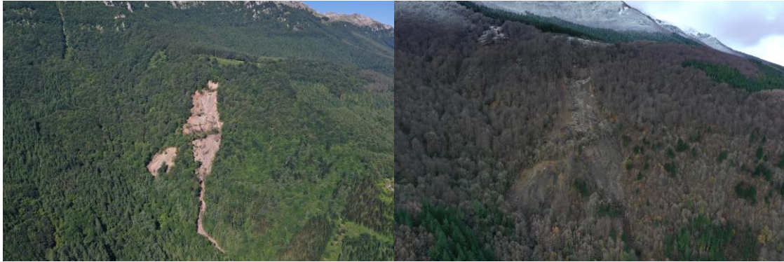
Figura 23: Imagen aérea oblicua de junio 2020 (izquierda), e imagen aérea oblicua de diciembre 2020 (derecha). Si bien esta última tiene menos luminosidad, a través de las hayas se puede ver mejor la pista intermedia que fue barrida por el deslizamiento.
