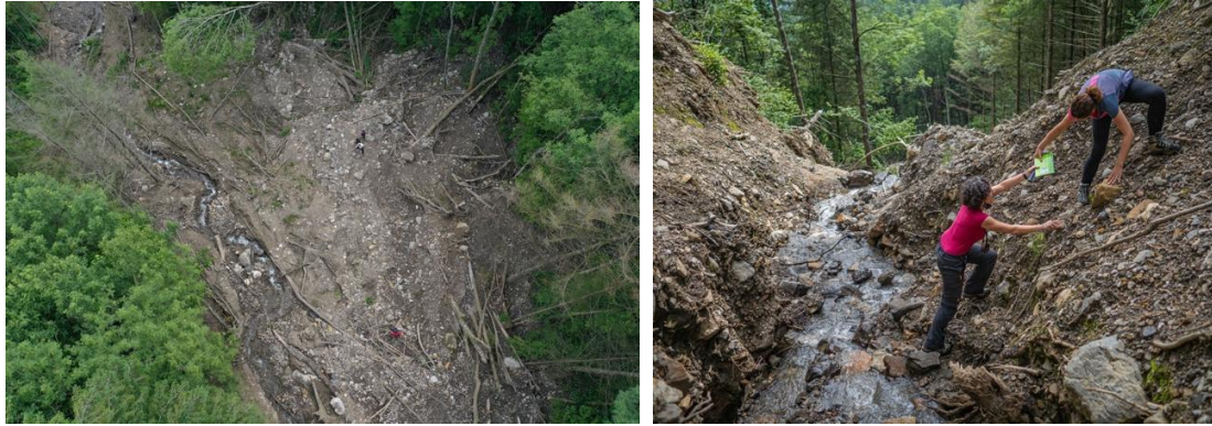
Figura 27: Fotografía aérea de la parte inferior del deslizamiento (izquierda), donde se observa la reciente incisión de la regata Gorospe al adecuarse al gran volumen de sedimentos removidos (derecha).
