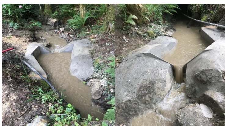
Figura 3: Fotos de la estación de aforo durante la primera fase de instalación, donde se completó la obra de instalación del vertedero y se colocaron la sonda de nivel y la regleta.
