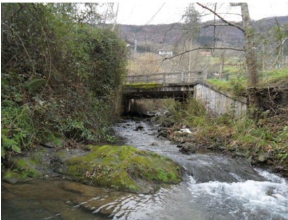
Harri-lubetaren estribua eta iturriranzko ur-eroanbidea. Estribo de escollera con conducción de agua hacia la fuente.
