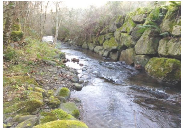
Harri-lubetak eskuinaldean, oztopotik errekan behera. Escolleras en MD aguas abajo del obstáculo.
