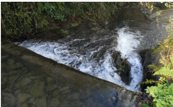
Fabrikaren xehetasuna isurketa-etzpainen. Detalle fábrica en labio de vertido.
