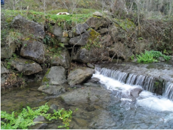
Harri-lubetaren estribua eta iturriranzko ur-eroanbidea. Estribo de escollera con conducción de agua hacia la fuente.
