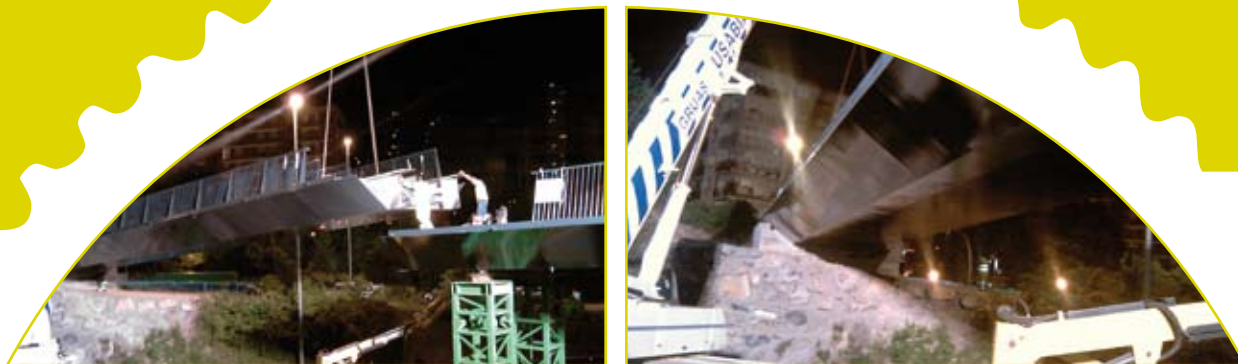
Momento de la instalación de la pasarela metálica.
