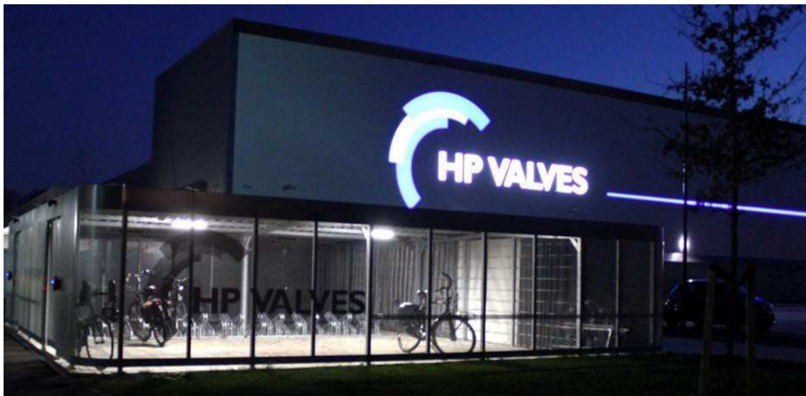
Ilustración 37. Aparcabis propiedad de la empresa HP Valves en Hengelo (Holanda).
