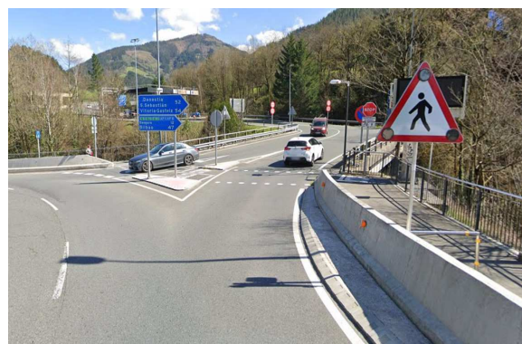
Ilustración 81. Intersección ciclista-peatón-vehículo a motor con paso ciclista, pero sin señalización vertical dirigida al tráfico motorizado. Itinerario 9.
