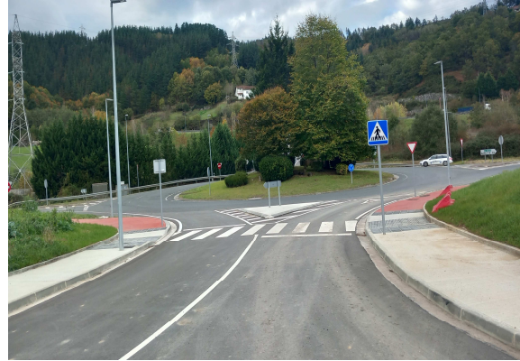
Ilustración 79. Intersección ciclista-peatón-vehículo a motor de nueva construcción sin señalización ciclista. Itinerario 6. Fotografía propia.
