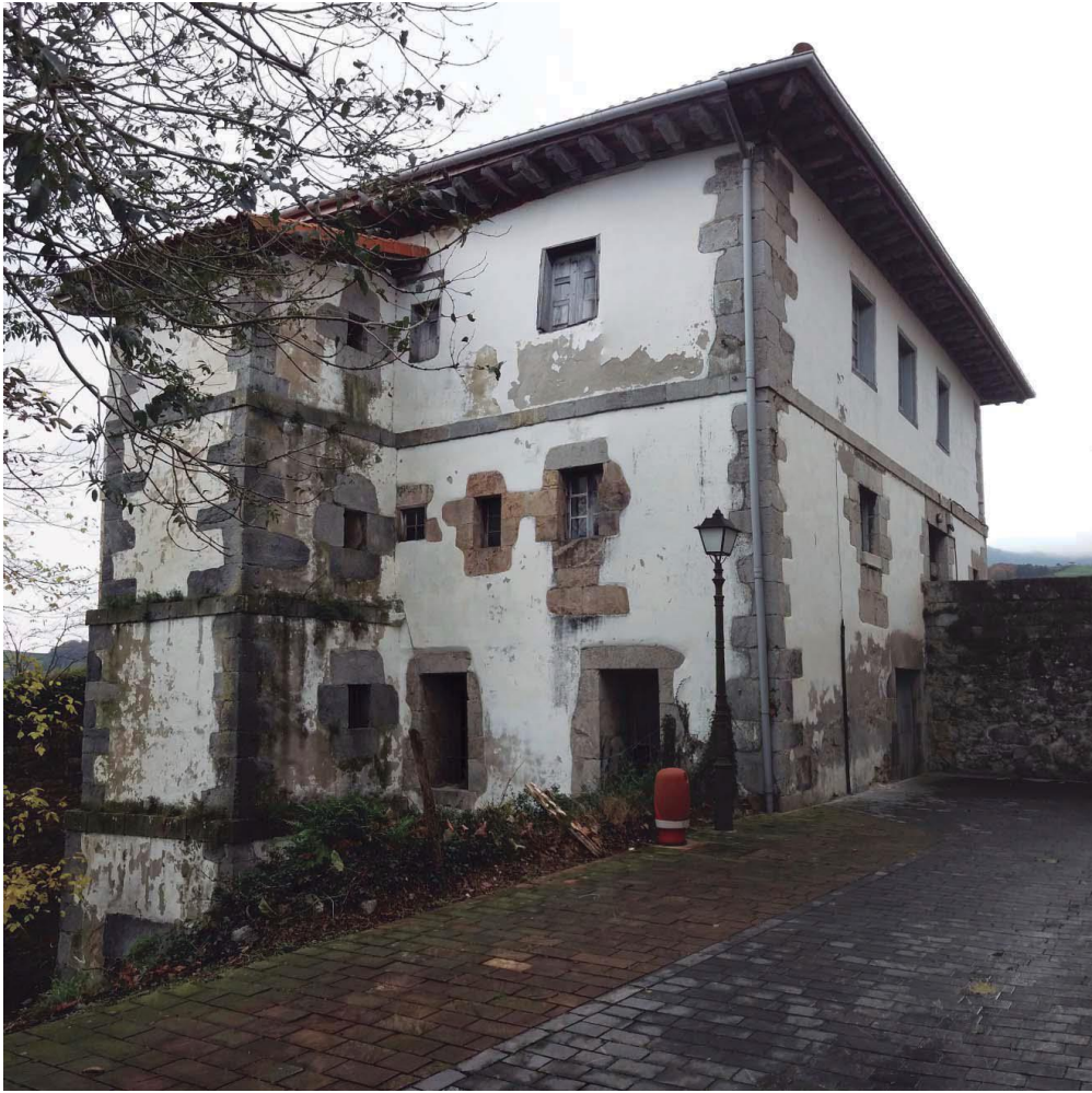
Figura 17: Estado actual de la vivienda vista desde el norte (Fuente: ZUMARPE KUDEAKETAK, S.L.)
