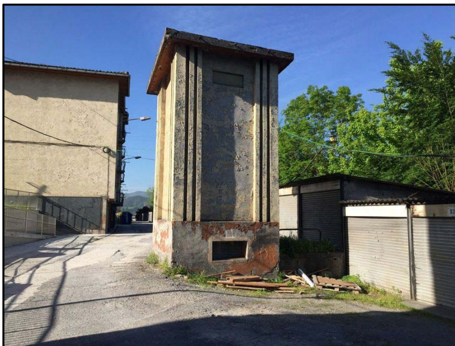
Ubicación de la Torre-Centro de Transformación de Electricidad obstaculizando la calle Cari de la Cruz, en el barrio de Ihurre.
