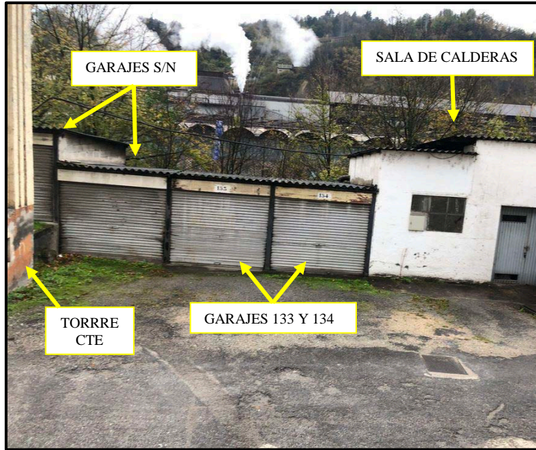
Ubicación de los elementos que se ven afectados por las actuaciones del Plan Especial
