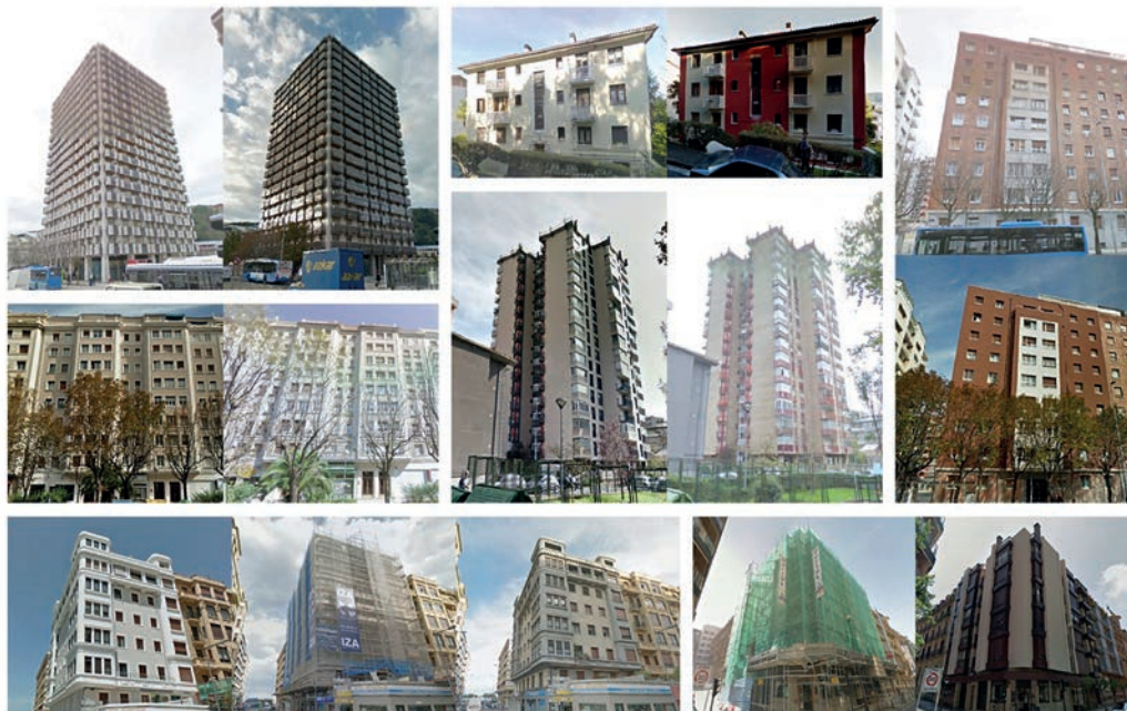
IMAGEN 33. Ejemplos de rehabilitaciones de edificios con criterios energéticos en Donostia-San Sebastián. Fuente: Dirección de Salud y Medio Ambiente del Ayuntamiento de Donostia-San Sebastián.
