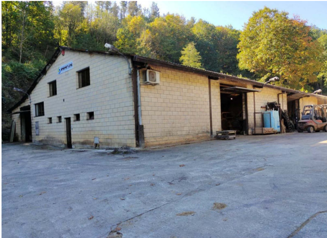
Instantánea en la que se plasma la parte delantera y central de la parcela “ b.10.1 “, primero de los pabellones edificados.
