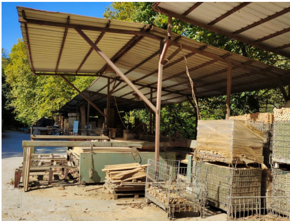
Cobertizo-almacén que se corresponde con la parcela " b.10.4 "
