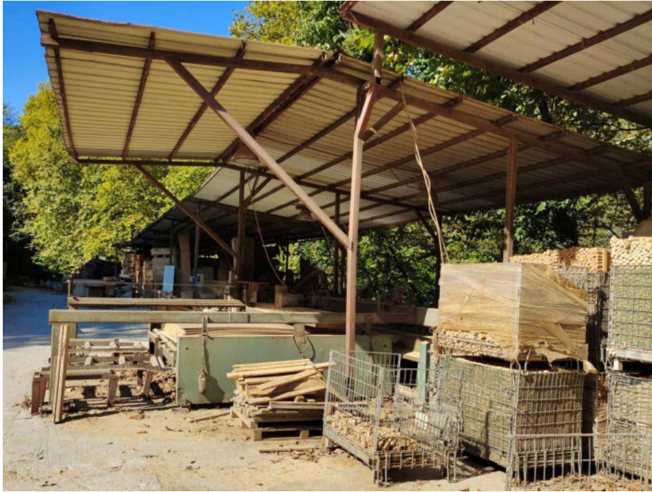
Cobertizo-almacén que se corresponde con la parcela “ b.10.4 “
