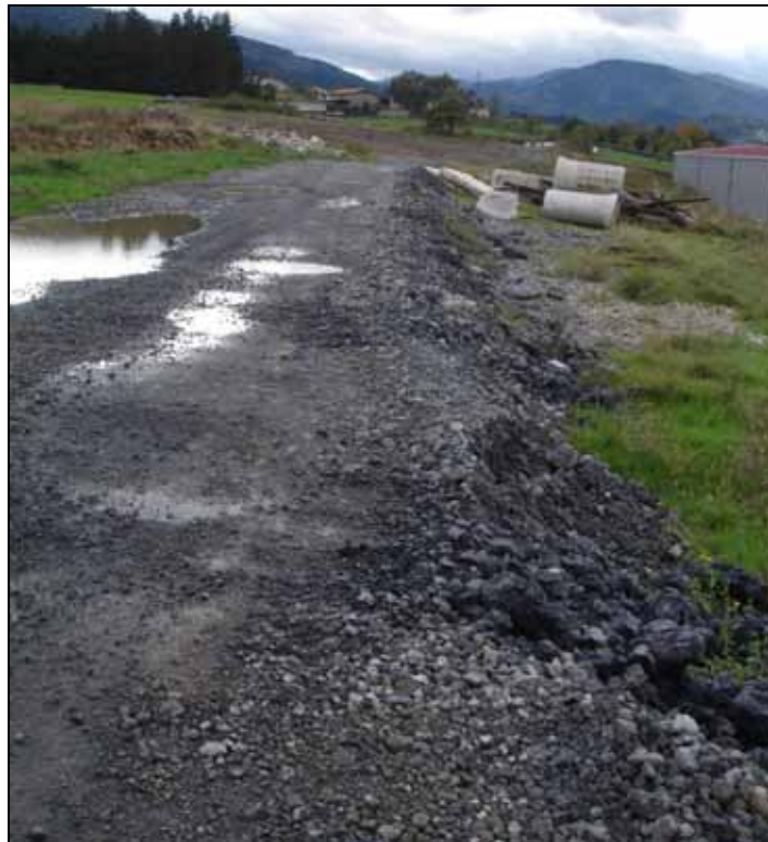
Empleo de escorias en el acceso al S-48
