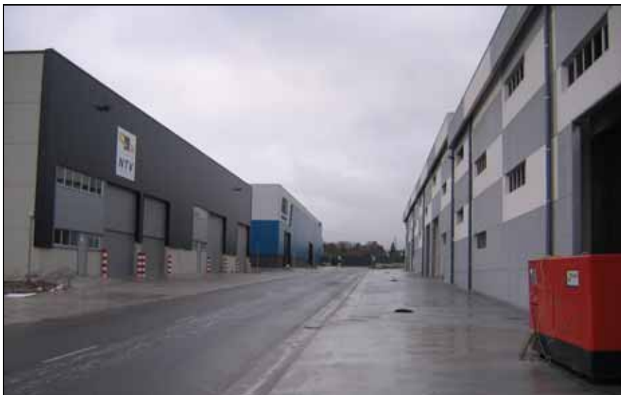
Obra de urbanización del S-41 “Altune” en su fase final de ejecución.
