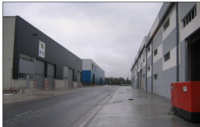
S-41 "Altune": exekuzioaren azkenengo aldia dagoen urbanizazio obra / S-41 "Altune": obra de urbanización en su fase final de ejecución
