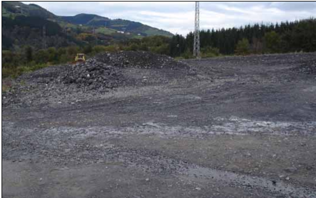
Zona de acopio de escorias de fundición en el S-48
