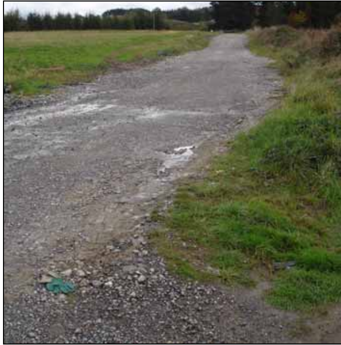
Empleo de escorias en el Camino de Herrigune
