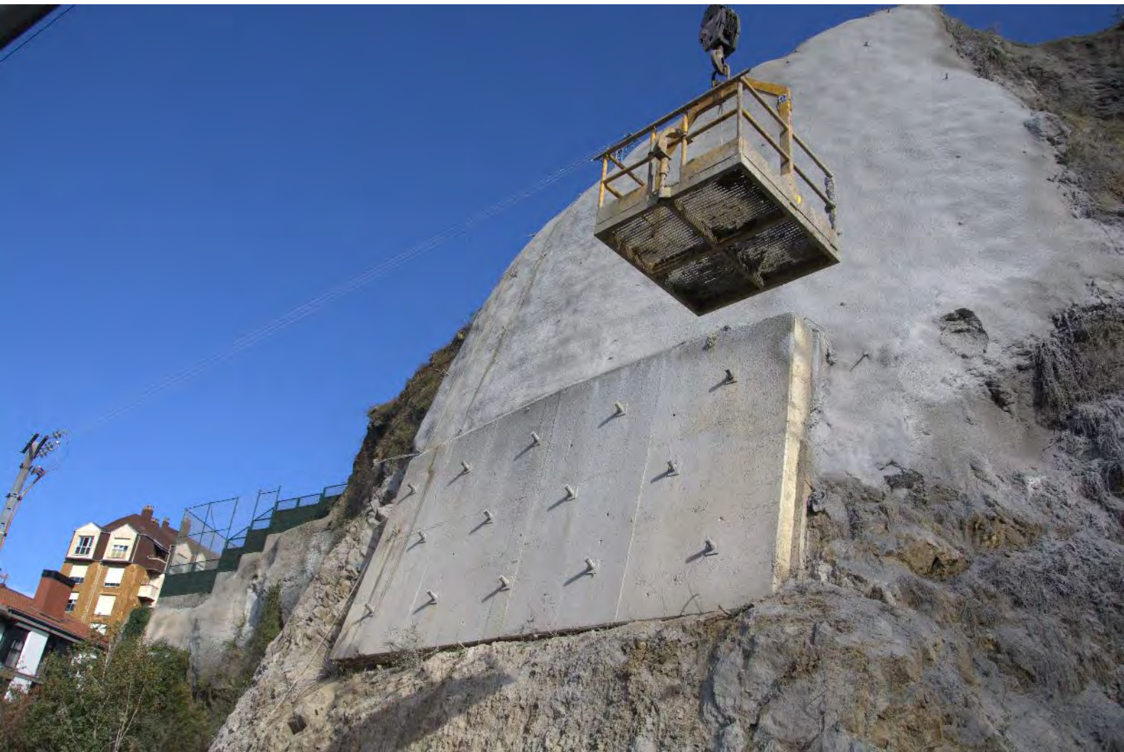
Foto 9: Labores de estabilización del talud de la cantera. Autor KRIPTA SL. Noviembre 2018
