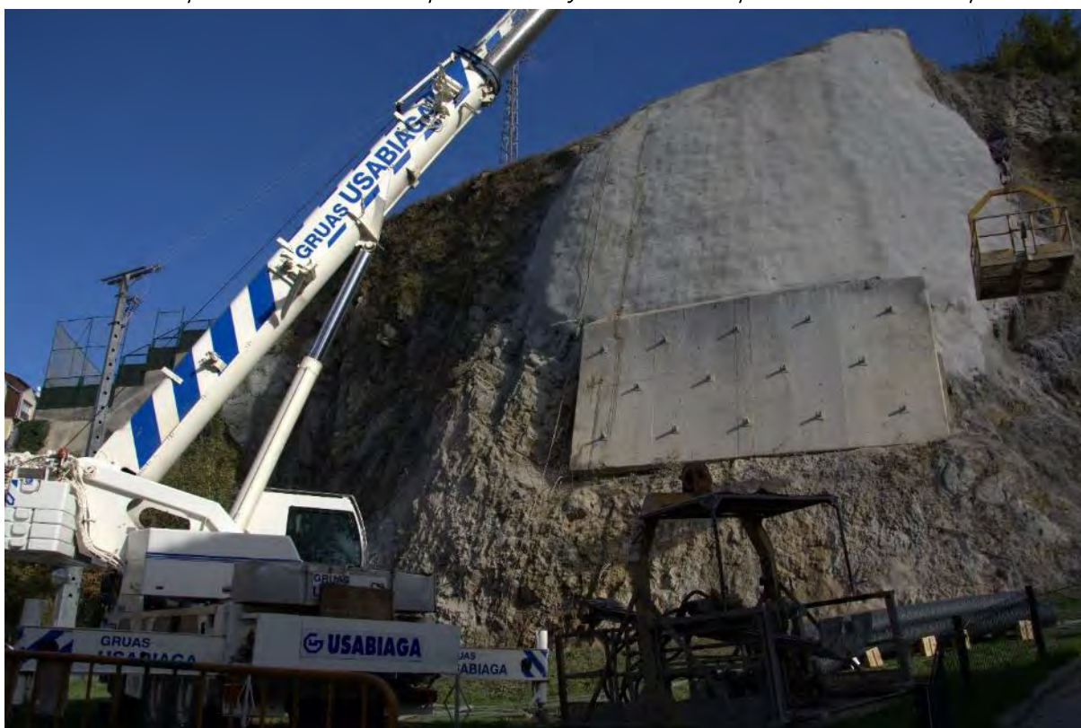
Fotografía 1: Imagen de las medidas de estabilización que se están realizando actualmente (noviembre de 2018) Autor: KRIPTA SL
