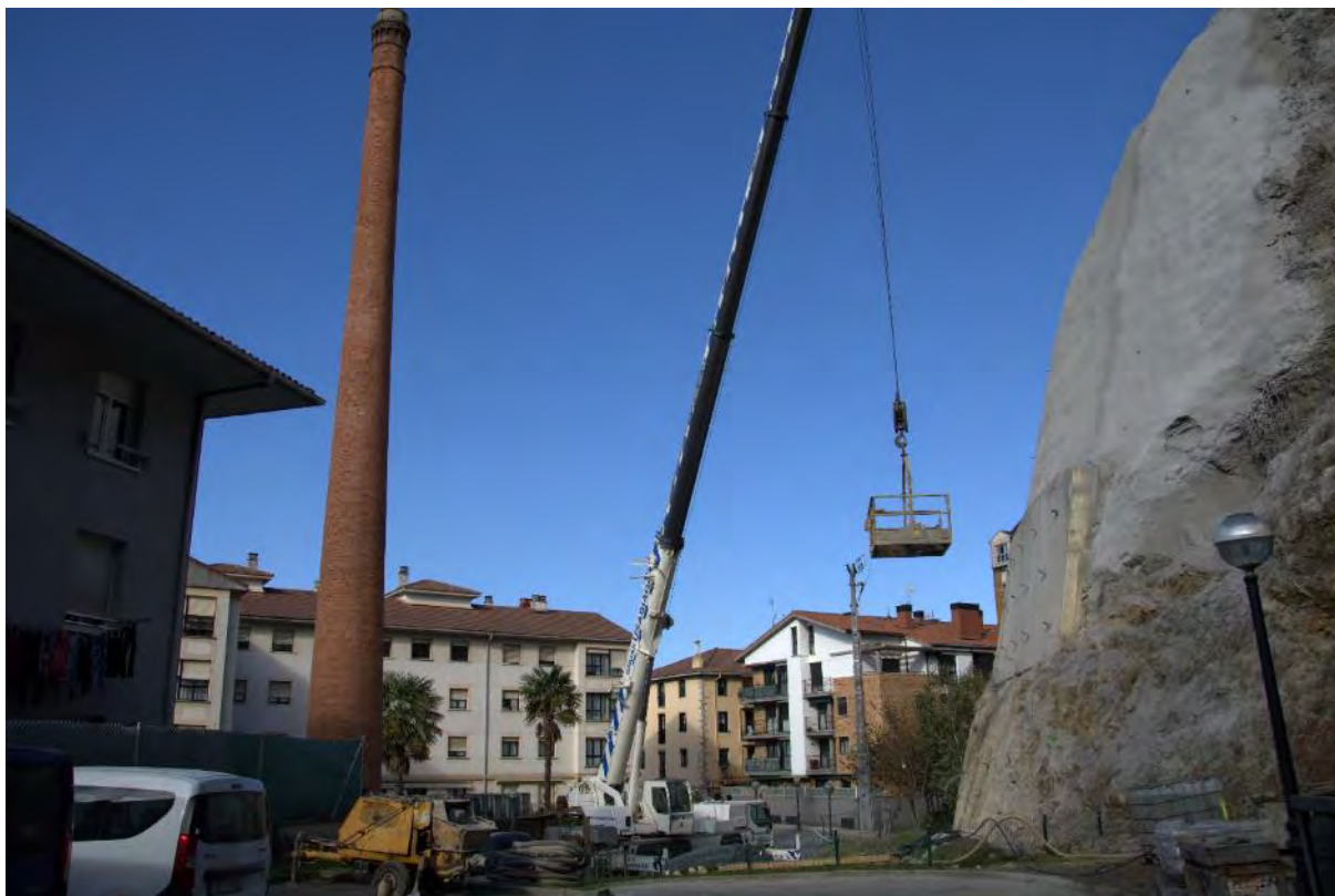
Foto 6: espacio donde se plantea la ampliación de la ikastola. Se aprecia el entorno urbano residencial. Autor KRIPTA SL.
