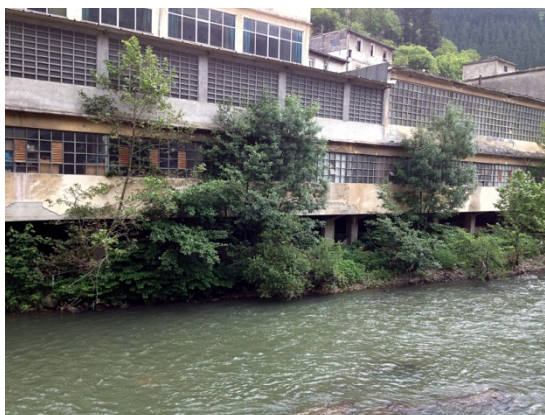
Edificación inmediata al cauce
