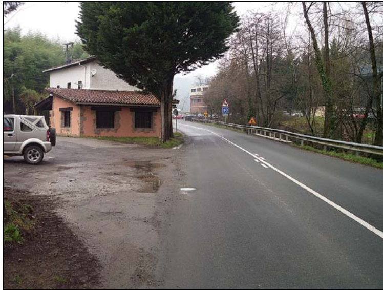
Carretera GI-3282 contigua al ámbito del Plan Parcial
