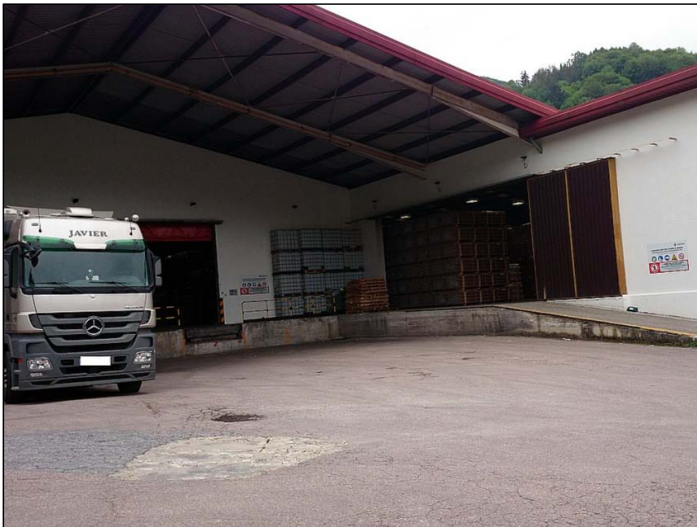
Nave industrial de la empresa Corenso Tolosana S.A. (17/05/2018)
