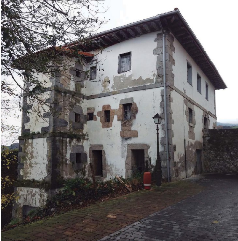
Vista del edificio desde el lindero noreste, en el que se observa el acceso a la planta baja.
