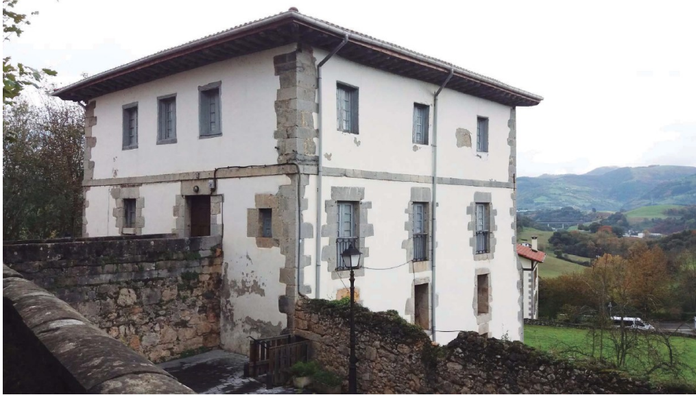
Vista del edificio desde el lindero noroeste, en el que se observan las fachadas norte y oeste, así como parte del acceso peatonal a la planta primera.
