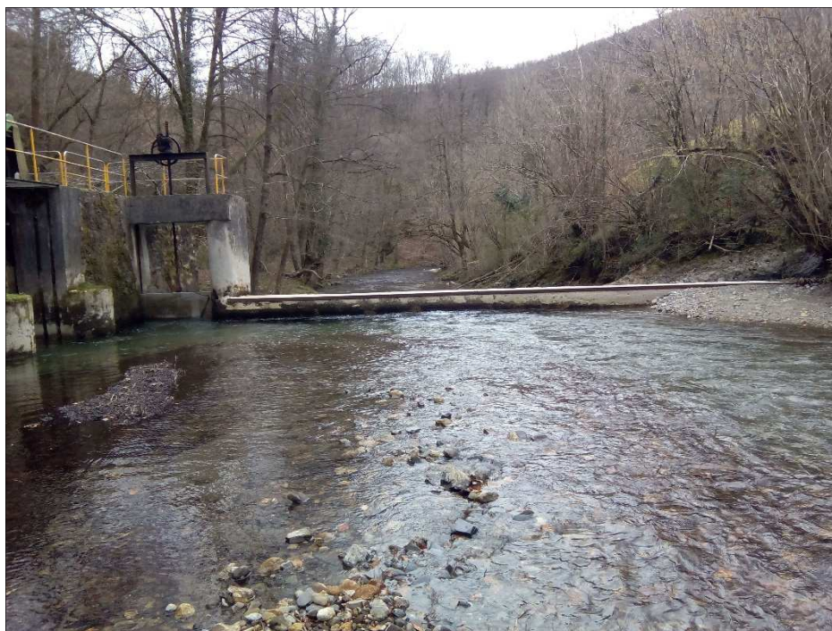
Fotografía nº1.- Azud de toma del CH Añarbe 2 en el río Añarbe
