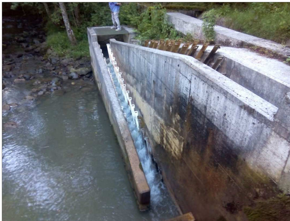
Fotografía nº 5.- Escala con ralentizadores o tipo denil
