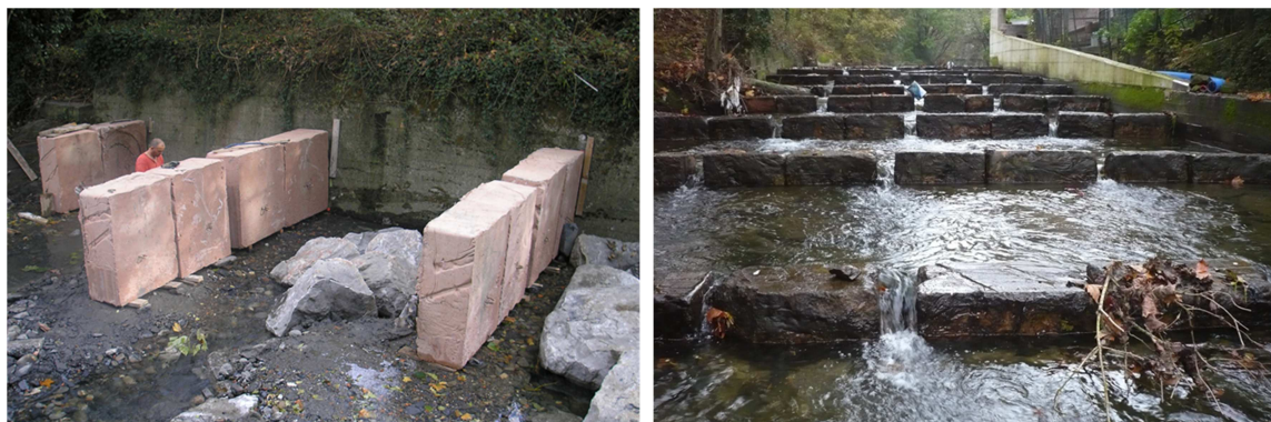
Fotografías nº2 y 3.- Rampas de diques
