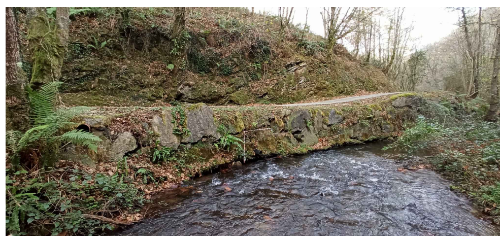
R1. AGUAS ARRIBA MARGEN IZQUIERDA. RECALCES DE ESCOLLERA A LO LARGO DE 25M
