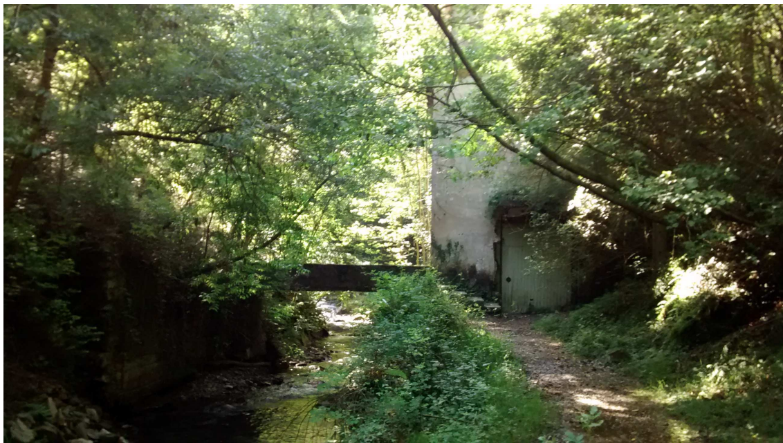
I.1.- VISTA GENERAL DESDE AGUAS ABAJO, EDIFICIO Y PASARELA.
