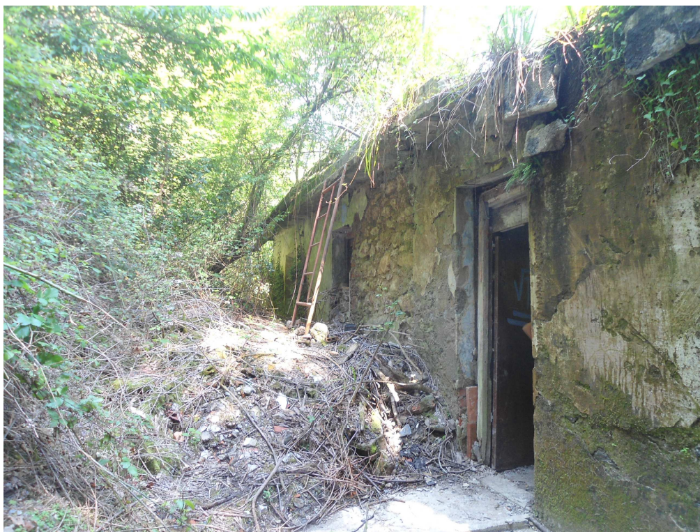
I.8.- PARTE TRASERA DEL EDIFICIO. PLANTA SUPERIOR.
