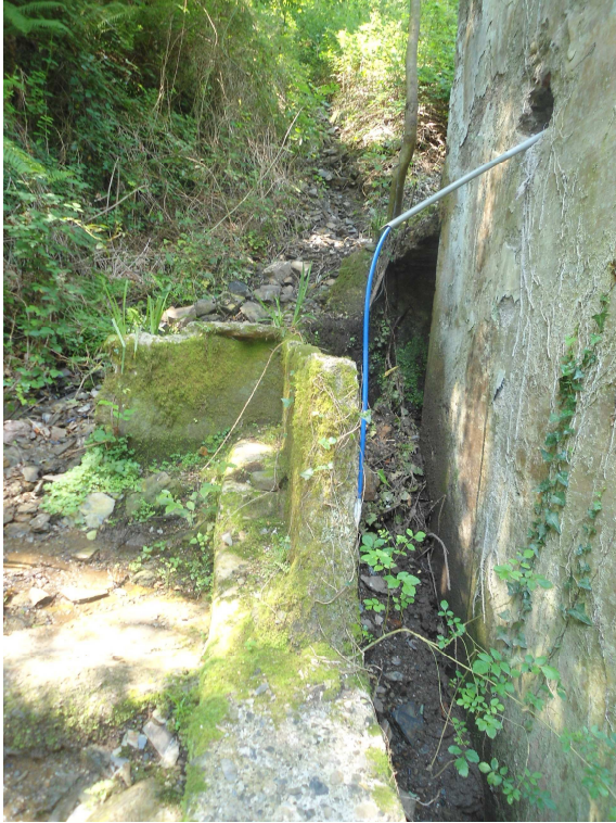
I.9.- LATERAL AGUAS ARRIBA DEL EDIFICIO
