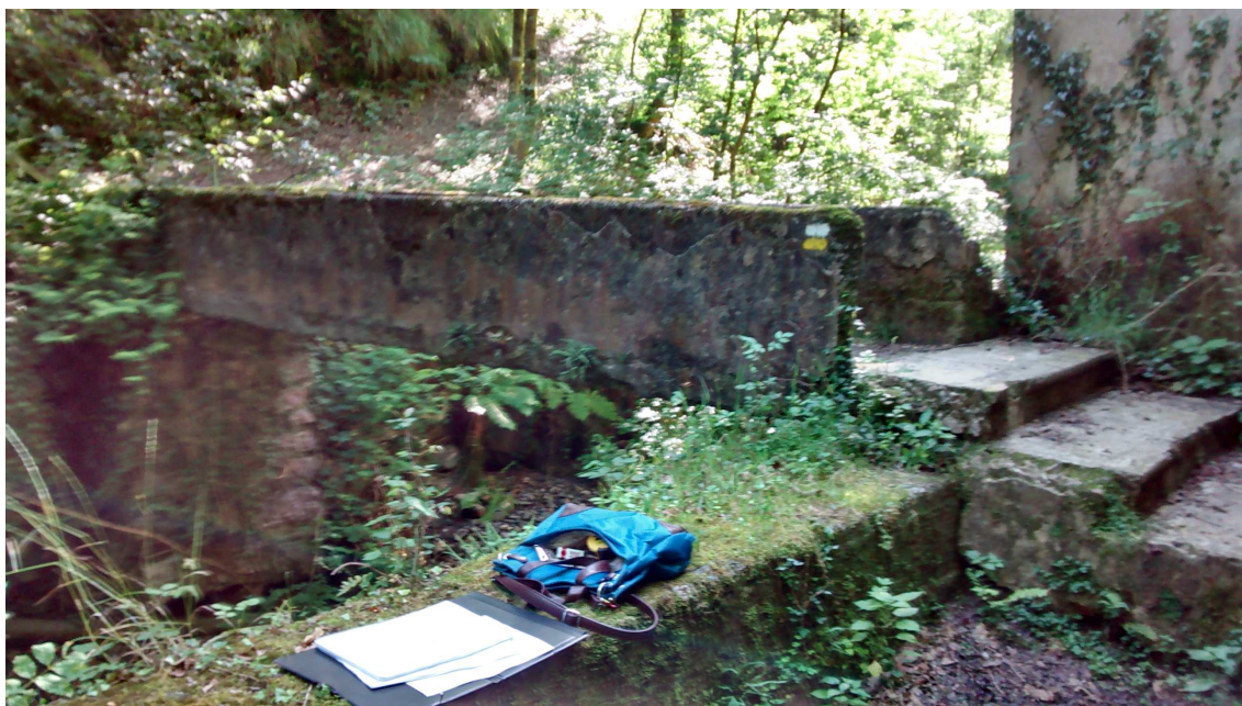
I.2.- PASARELA Y MUROS ENCAUZAMIENTO.
