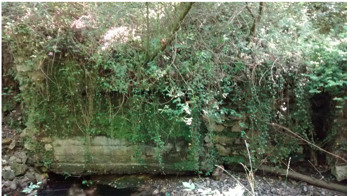
I.3.- MURO ENCAUZAMIENTO DE HORMIGÓN Y MAMPOSTERÍA DE LA MARGEN DERECHA.
