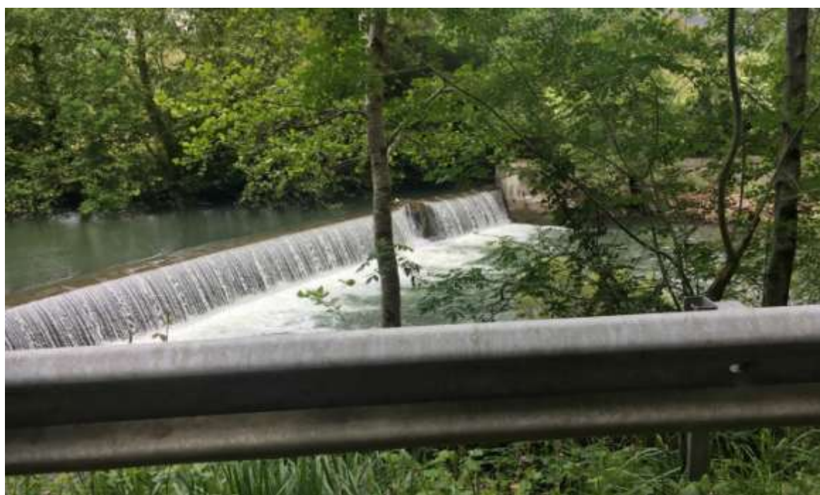
Fotografía nº10.- Azud de la Central Hidroeléctrica Altuna-Txiki.
