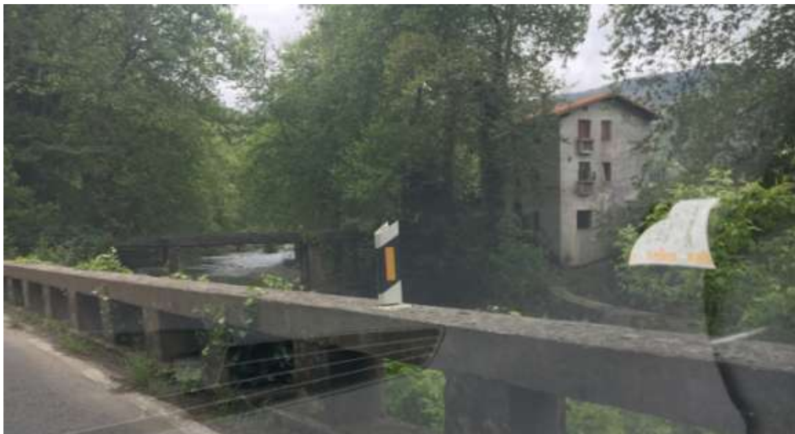
Fotografía nº9.-Central Hidroeléctrica Altuna-Txiki y pasarela peatonal .
