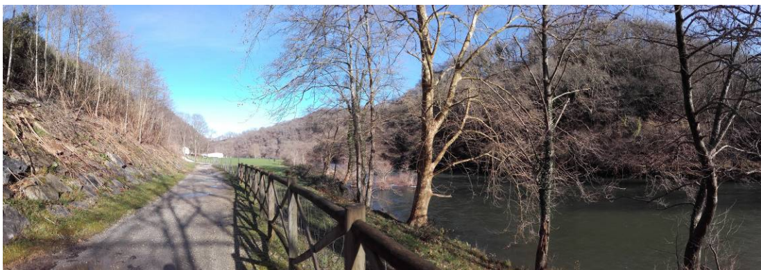
Imagen 3. Vista general desde la margen izquierda (Sección 1677.233)
