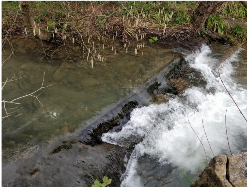
Vista del obstáculo. Foto tomada desde la margen derecha
