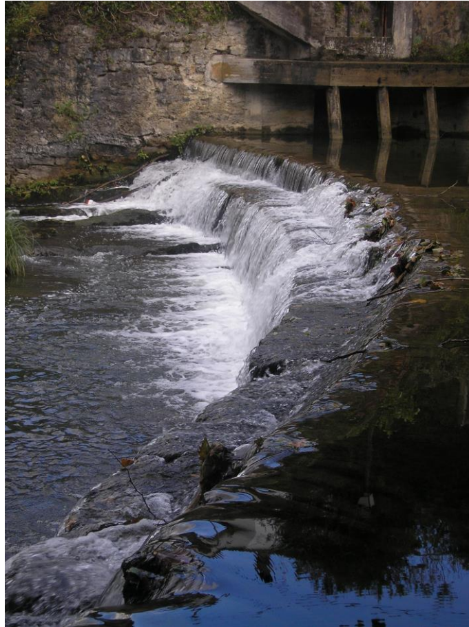
Vista del azud desde el estribo izquierdo
