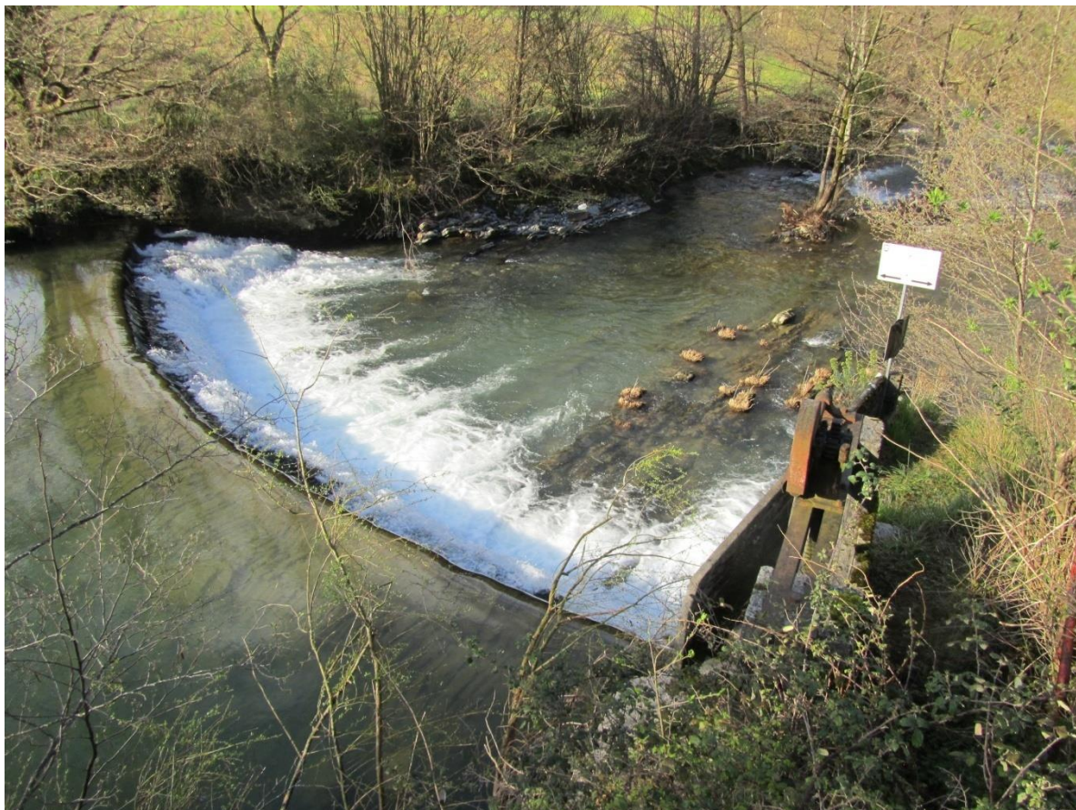
Azud La Serrería. Afloramientos rocosos en cauce y estribo derecho del azud
