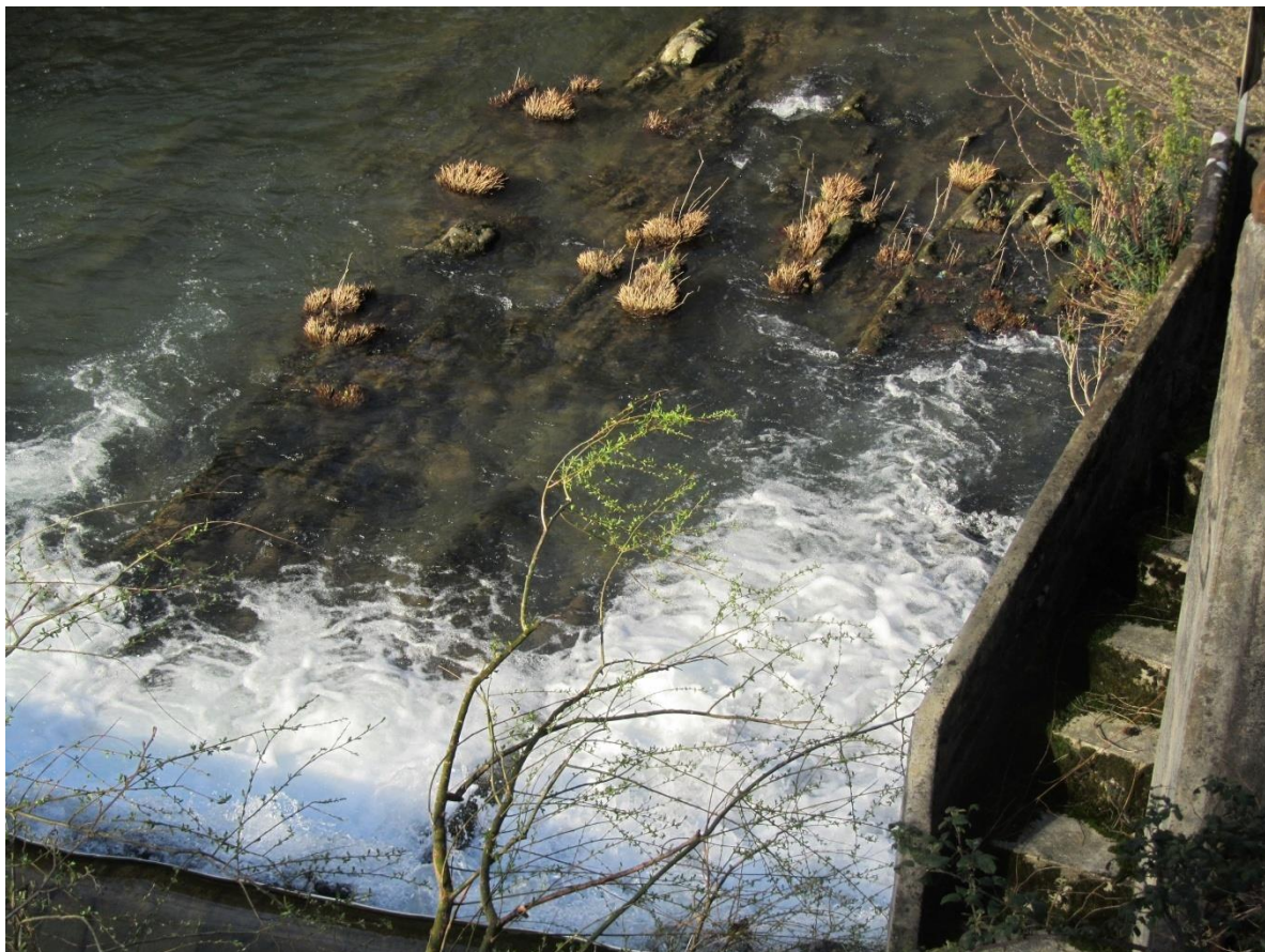
Azud La Serrería. Afloramientos rocosos en cauce y estribo izquierdo del azud
