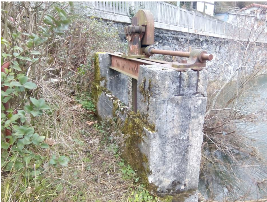
Vista de la estructura de las compuertas de entrada al canal
