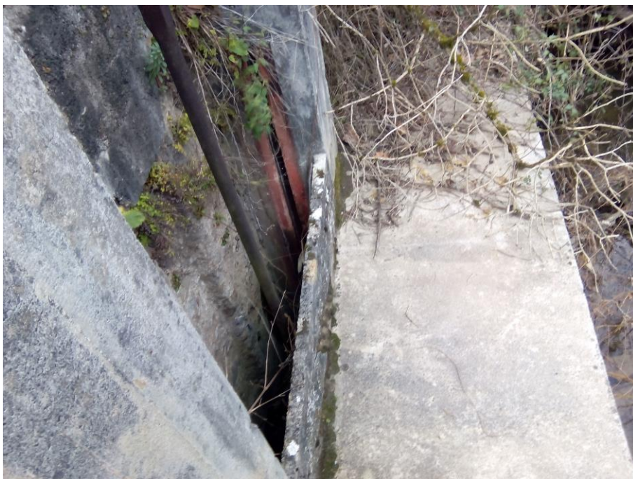
Vista de la parte baja de las compuertas de entrada al canal
