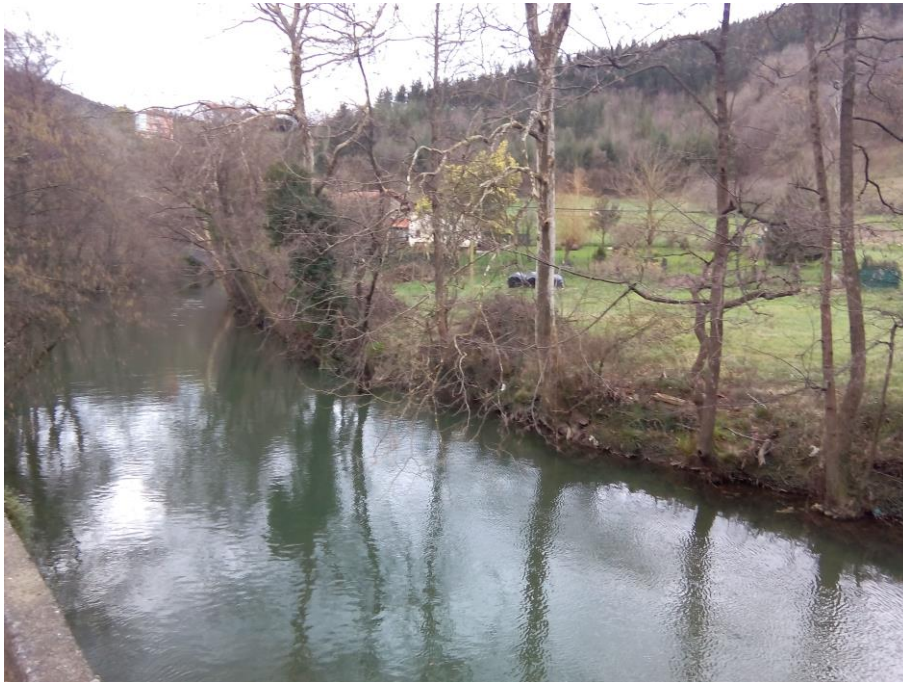
Zona del camino de acceso al estribo izquierdo del azud
