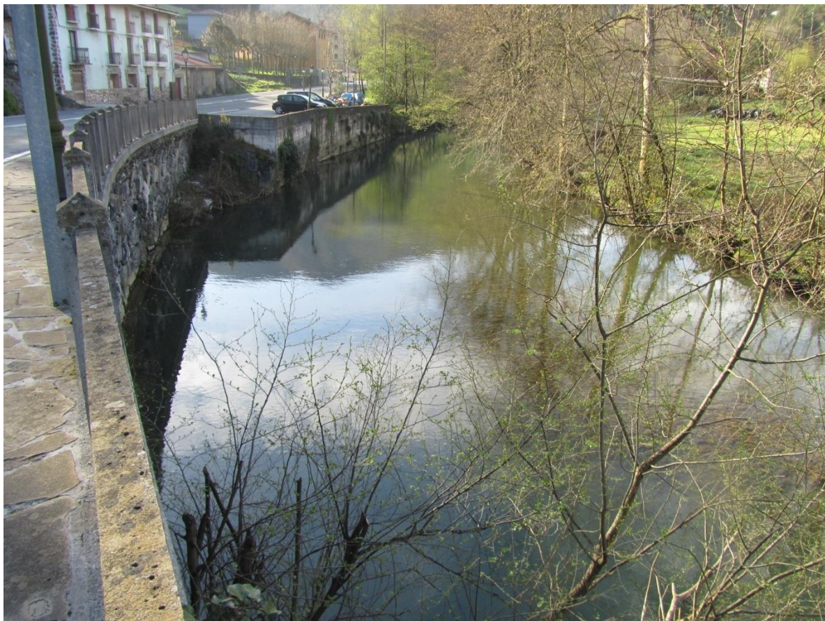
Muro de aparcamiento (margen derecha) y llanura de inundación (margen izquierda)
