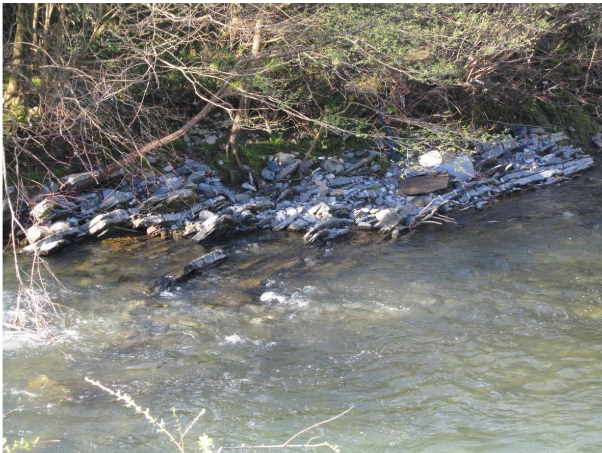
Azud La Serrería. Afloramientos rocosos en la margen izquierda del cauce
