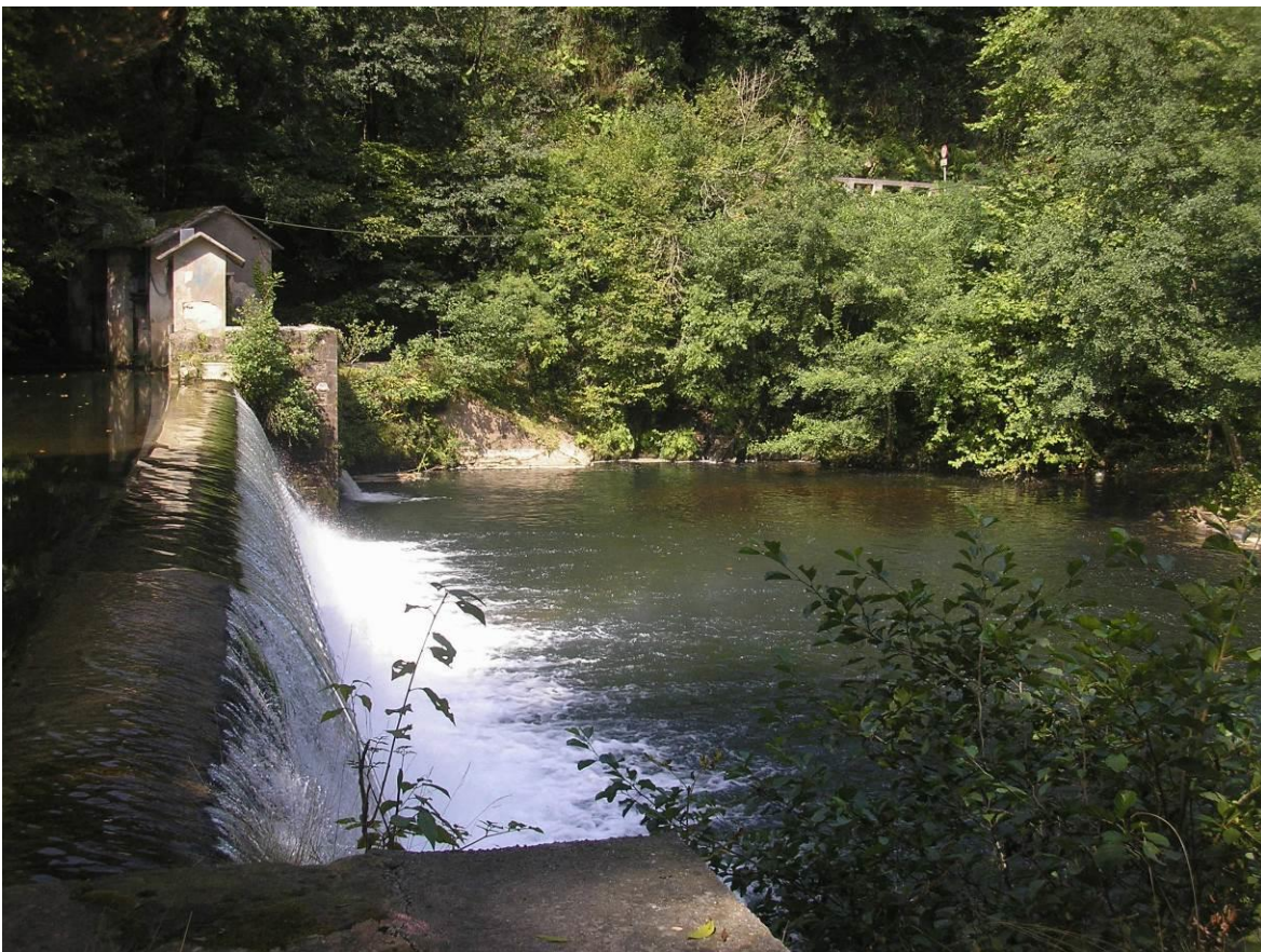
Vista desde el azud hacia aguas abajo
