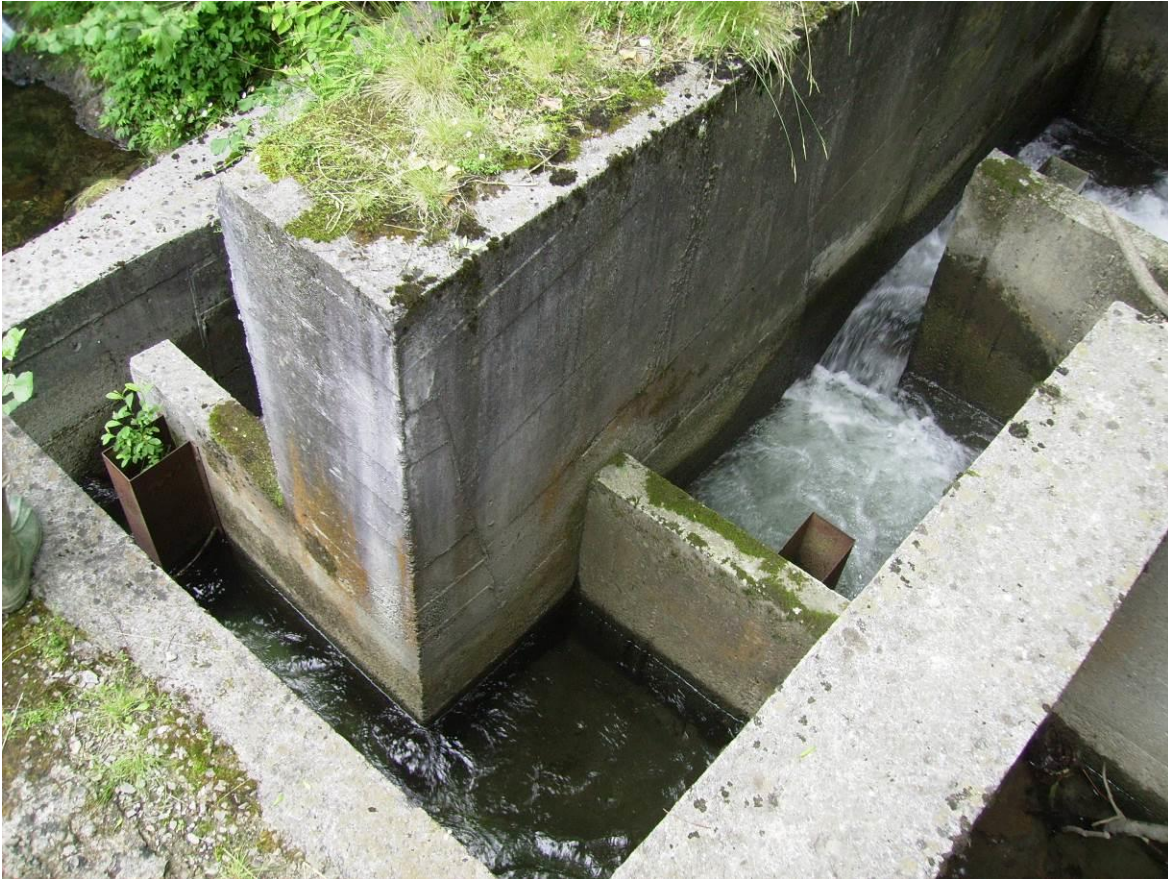
Quiebro entre segundo y tercer tramo de la escala actual
