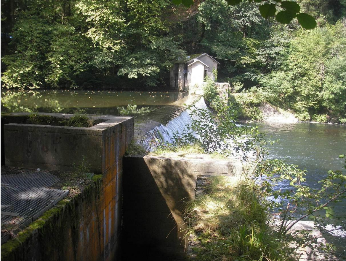
Vista del azud desde la margen derecha. Zona de la escala para peces
