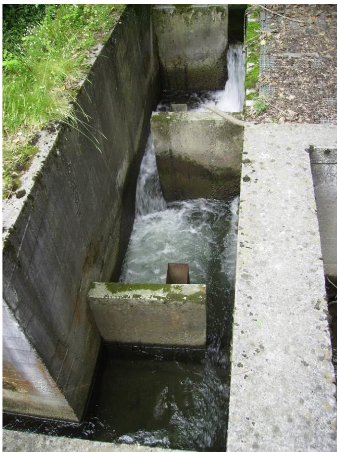
Segundo tramo de la escala actual
