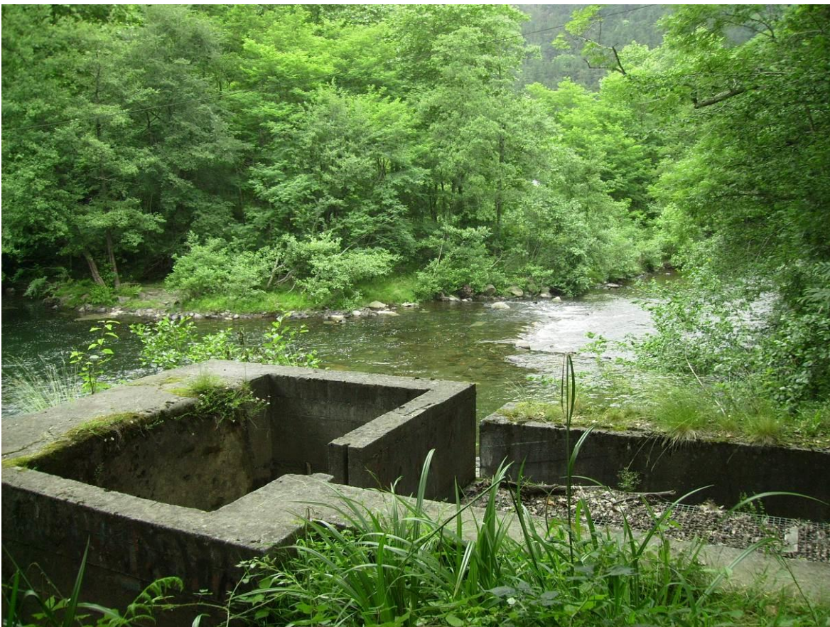
Entrada a la escala y primer tramo de la misma
