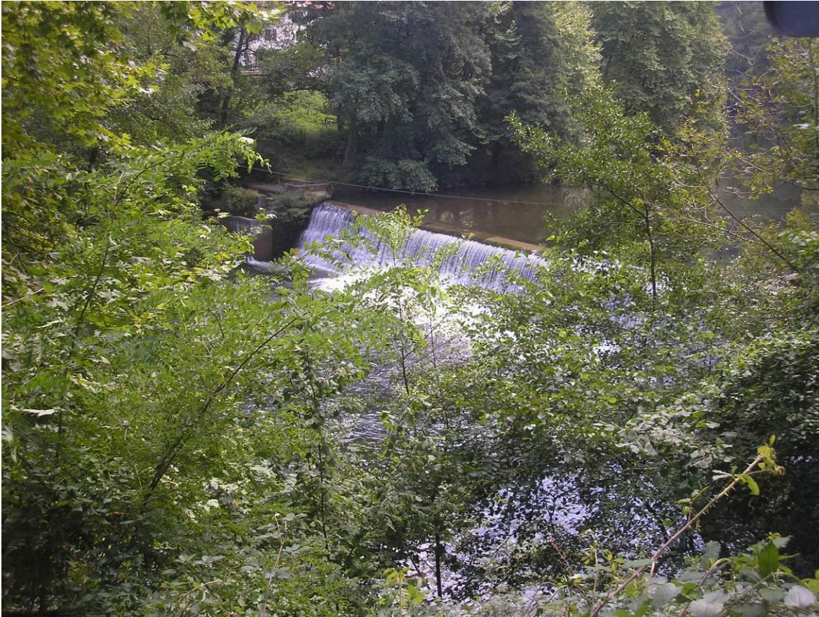
Vista del azud desde la carretera GI-3410
