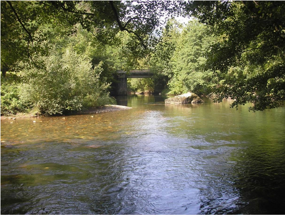
Comienzo del tramo en estudio aguas abajo, desde la margen derecha.
