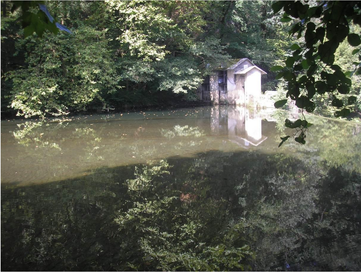
Remanso aguas arriba del azud y vista de la estructura de toma
