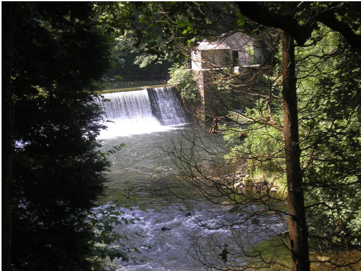
Detalle de la zona de la toma del canal en la margen izquierda
