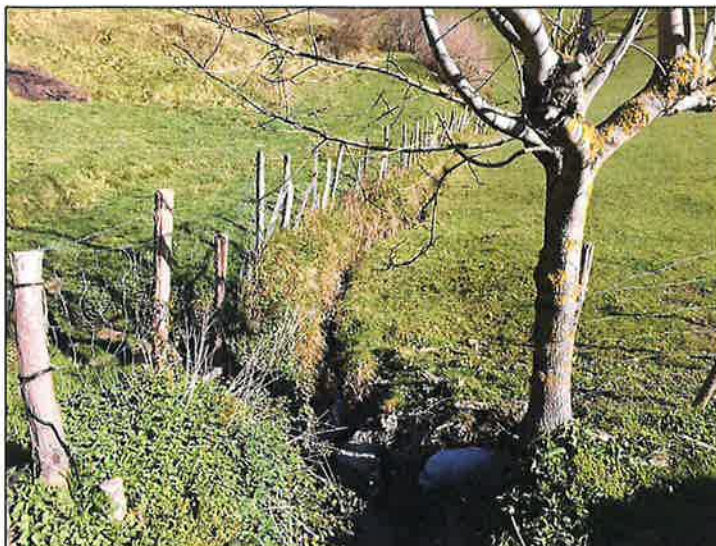
Aspecto del arroyo Aibelar en la zona del deslizamiento entre los p.k. 2,270 y 2,350
