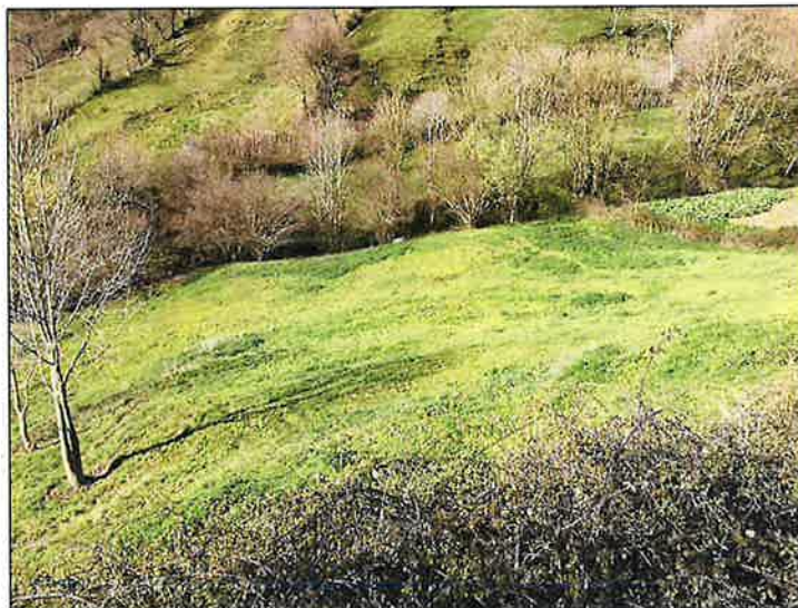
Aspecto del arroyo Aibelar en la zona del deslizamiento entre los p.k. 1,370 y 1,470
