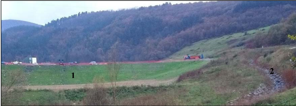
1. Frente del relleno, según estado de desarrollo a 5/11/2014 y 2. Cuneta perimetral
