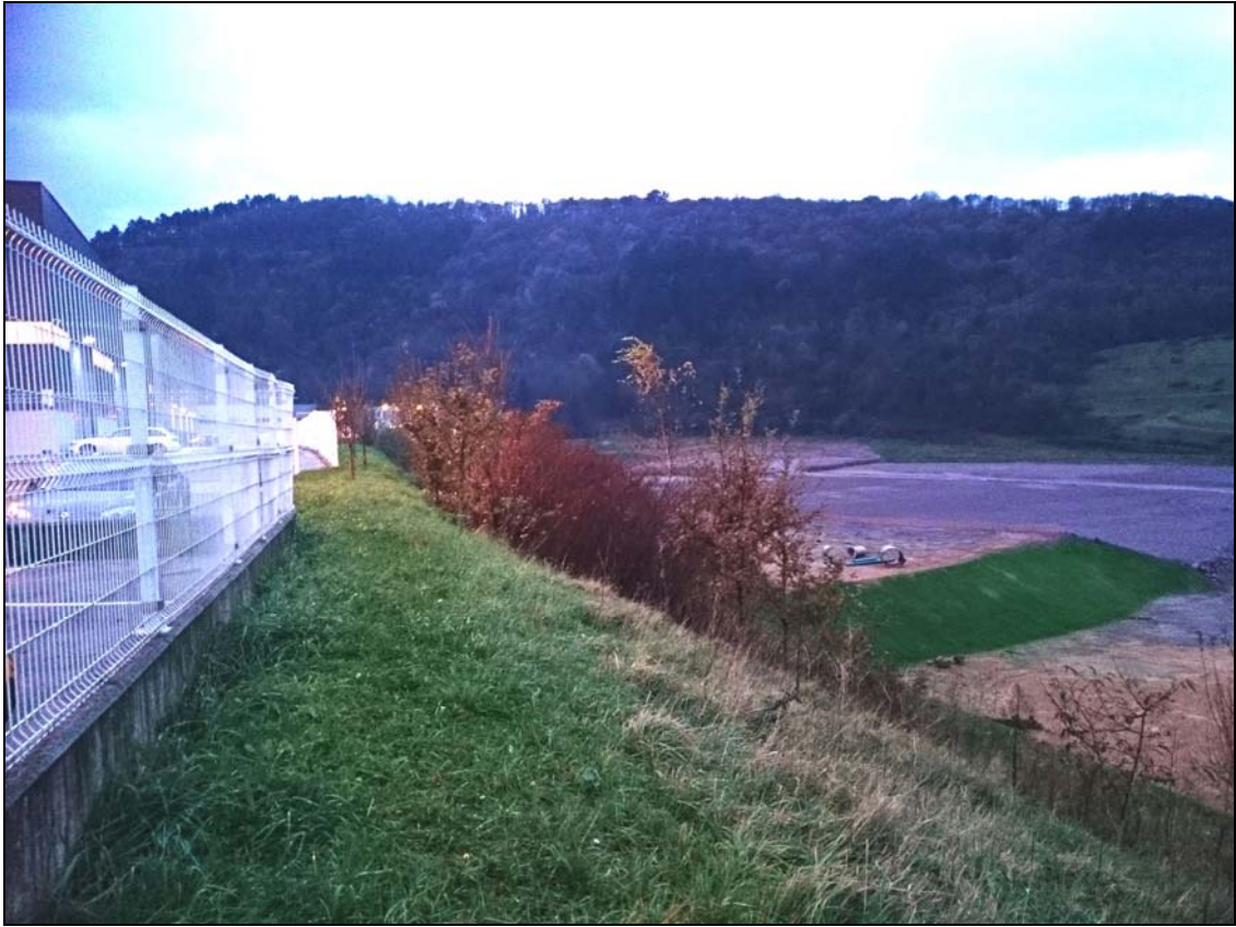
Ámbito de 2ª modificación de Normas aguas arriba, y en continuidad con la primera fase del polígono industrial Apattaerreka. Trabajos del relleno en el ámbito, según estado de desarrollo a 5/11/2014.
