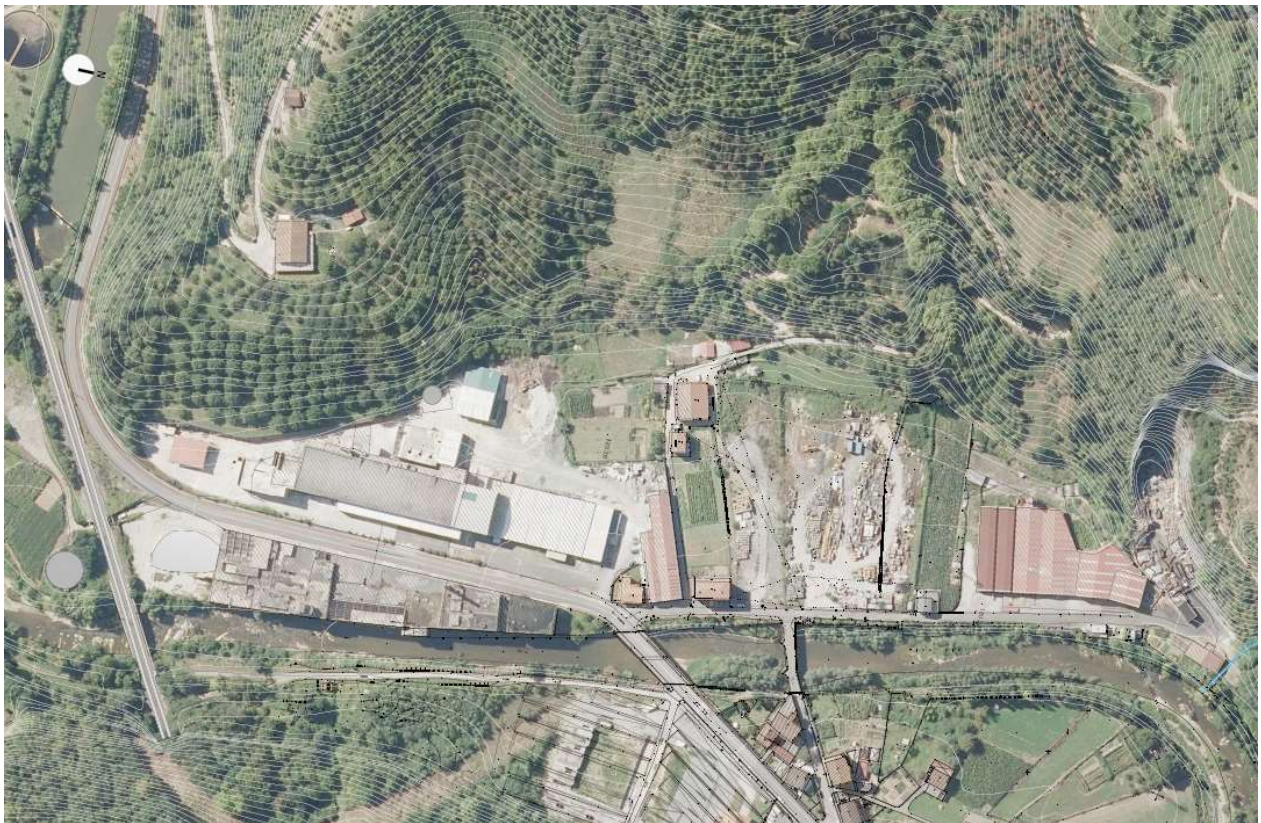
Estado actual de los ámbitos de Ajoain e Iztator
