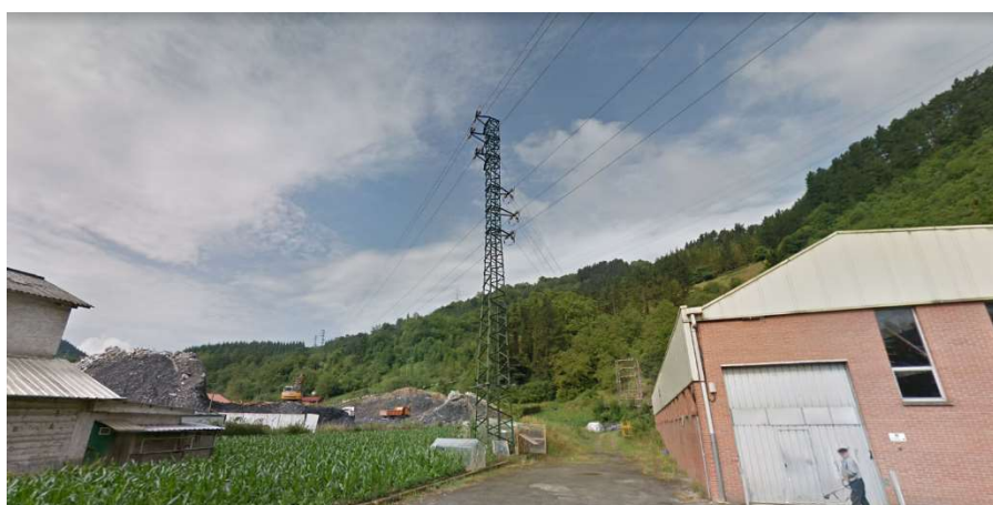
Línea eléctrica existente en el ámbito
