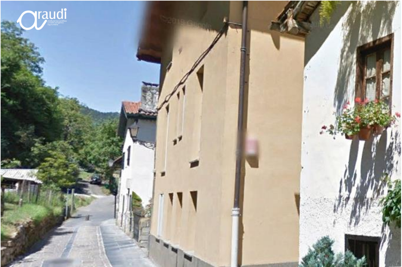
Fotografía del edificio grafiado como C de la propuesta de modificación de las NNSS de Asteasu
