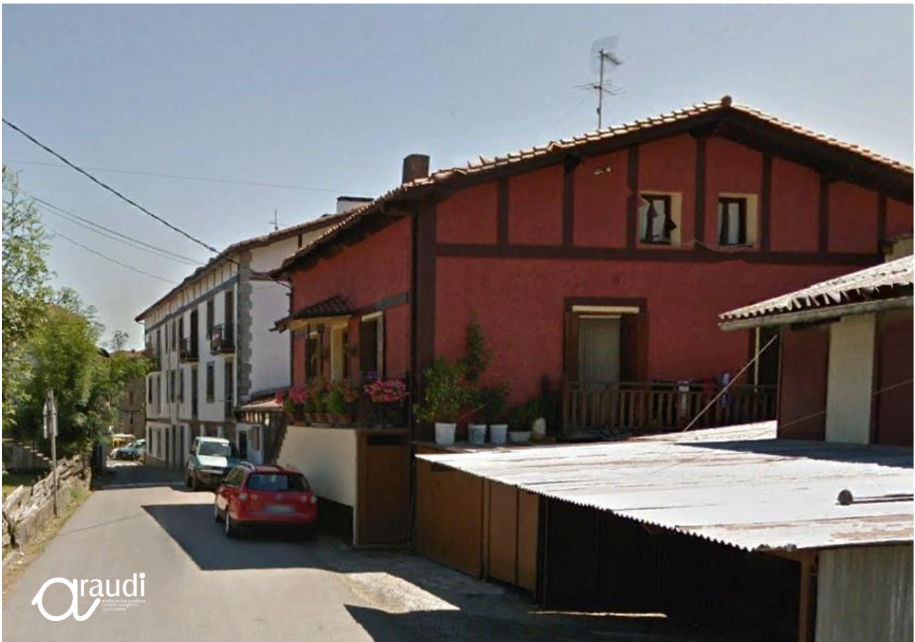
Fotografía del edificio grafiado como A de la propuesta de modificación puntual de las NNSS de Asteasu. Fuente Google maps
