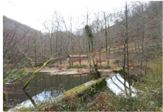
Imagen 5. Margen izquierda de la zona de aguas remansadas, algún aliso en el borde del agua, sobre la zona de acúmulo de sedimentos y plantación de Quercus rubra .
