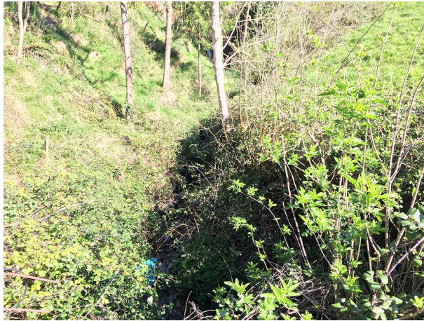
Aspecto del arroyo Aibelar debajo de la zona afectada por el relleno.
