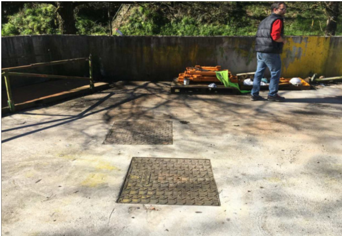
Fotografía nº3.- Arqueta bajo la que se halla situada la estación depuradora de Laga Poes, S.L
