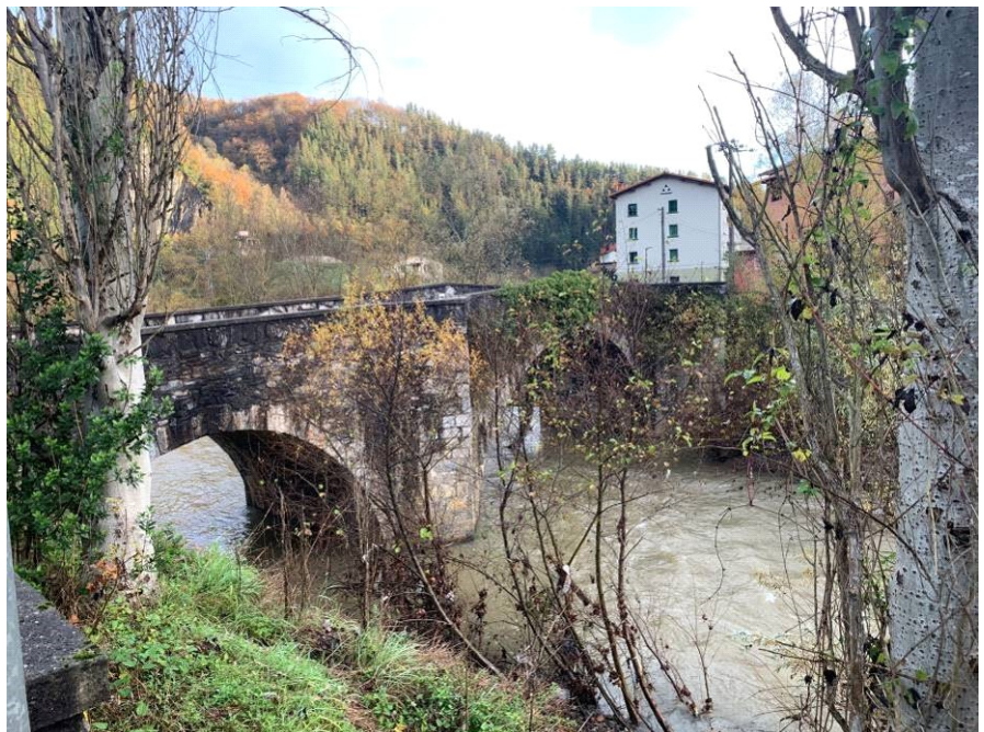
Fotografía 2: Aspecto del Puente Zubizaharra.
