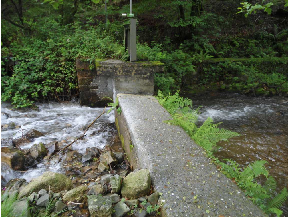
I.1.- AZUD PENADEGI. VISTA DESDE LA MARGEN DERECHA.
