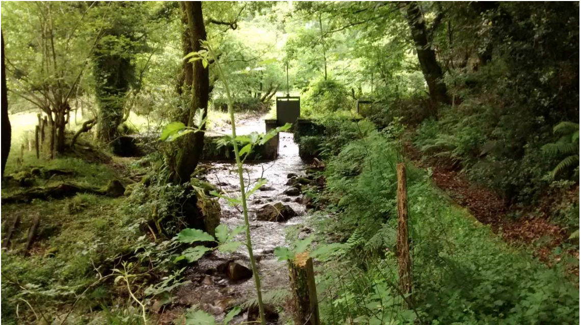
I.3.- VISTA DESDE AGUAS ABAJO. AZUD Y CANAL.
