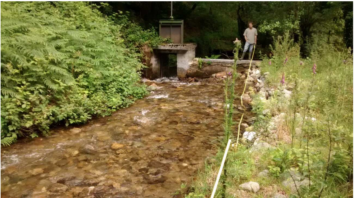
I.4.- VISTA DEL AZUD DESDE AGUAS ARRIBA.
