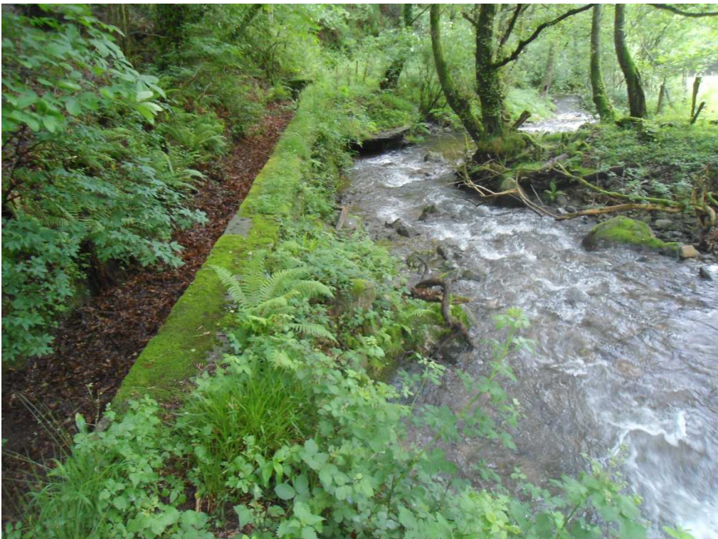
I.2.- CANAL PENADEGI. VISTA DESDE LA TOMA HACIA AGUAS ABAJO.
