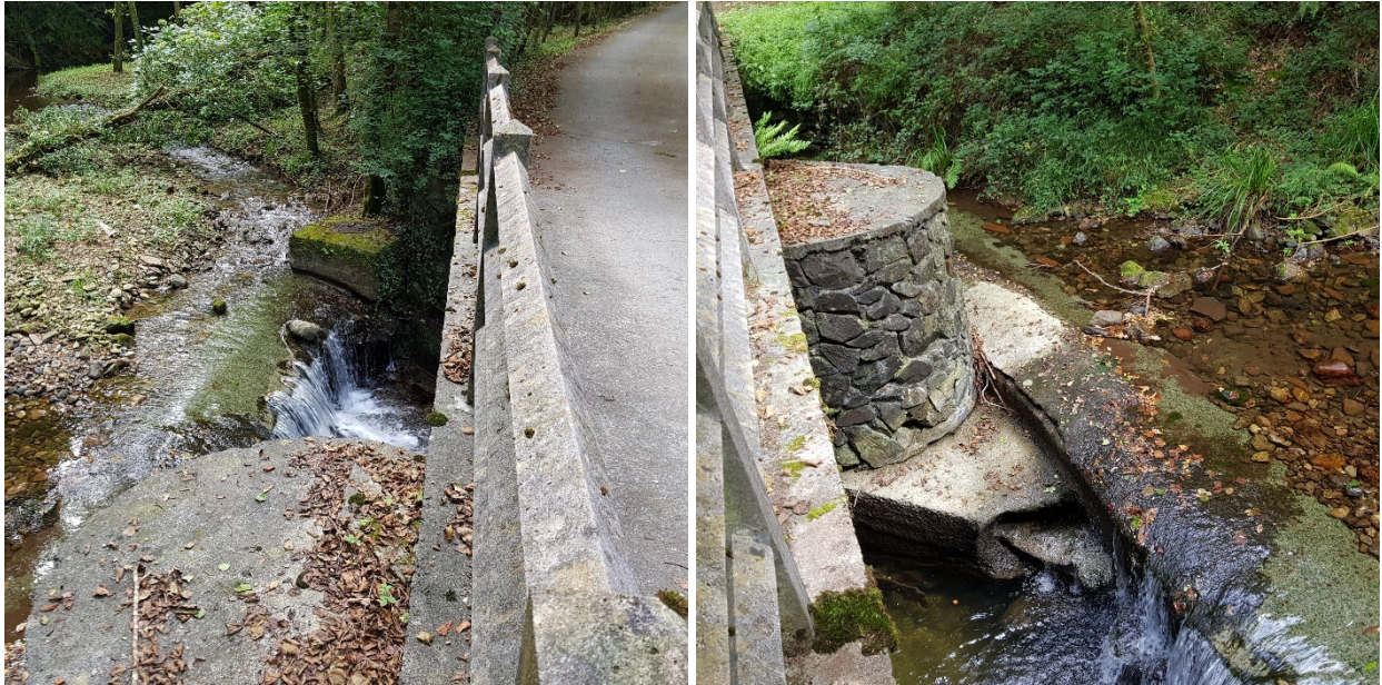
Vista actual del azud Aiendola, vista desde la estructura, aguas arriba
