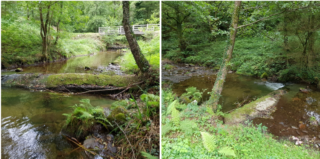
Vista actual del azud Txabola, vista hacia aguas arriba
