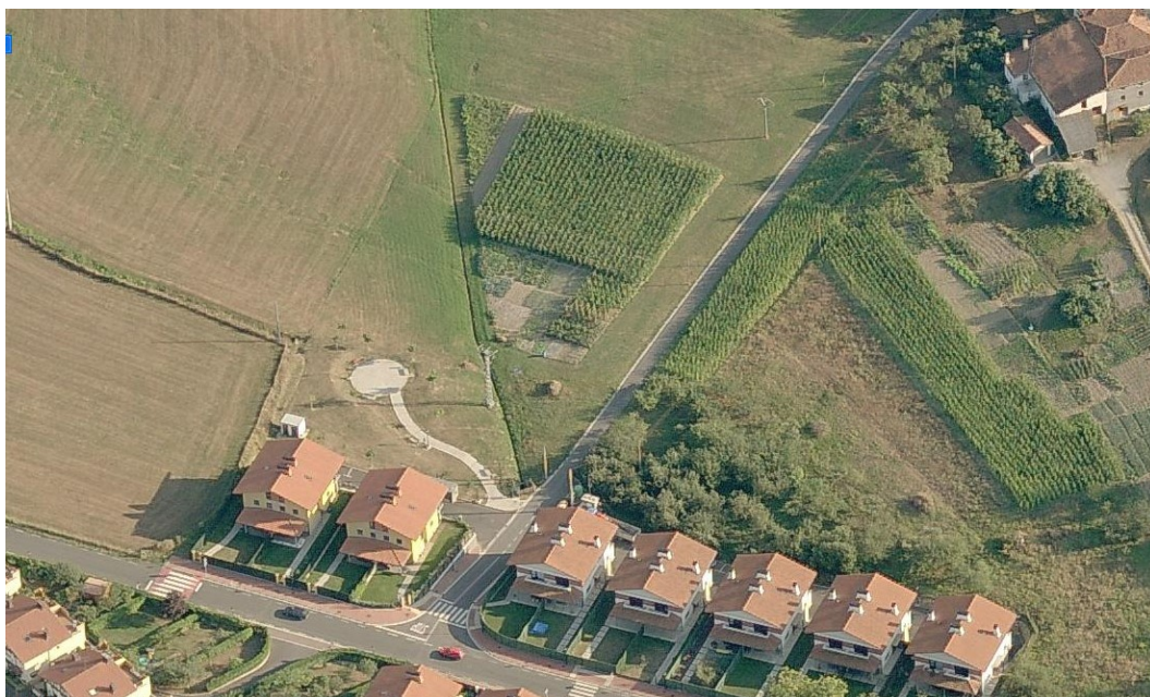
Entorno del Sector 1. Los edificios que figuran en el pie de la foto, forman parte del Sector R-1 - ATARI, desarrollado con arreglo a las anteriores Normas Subsidiarias.
