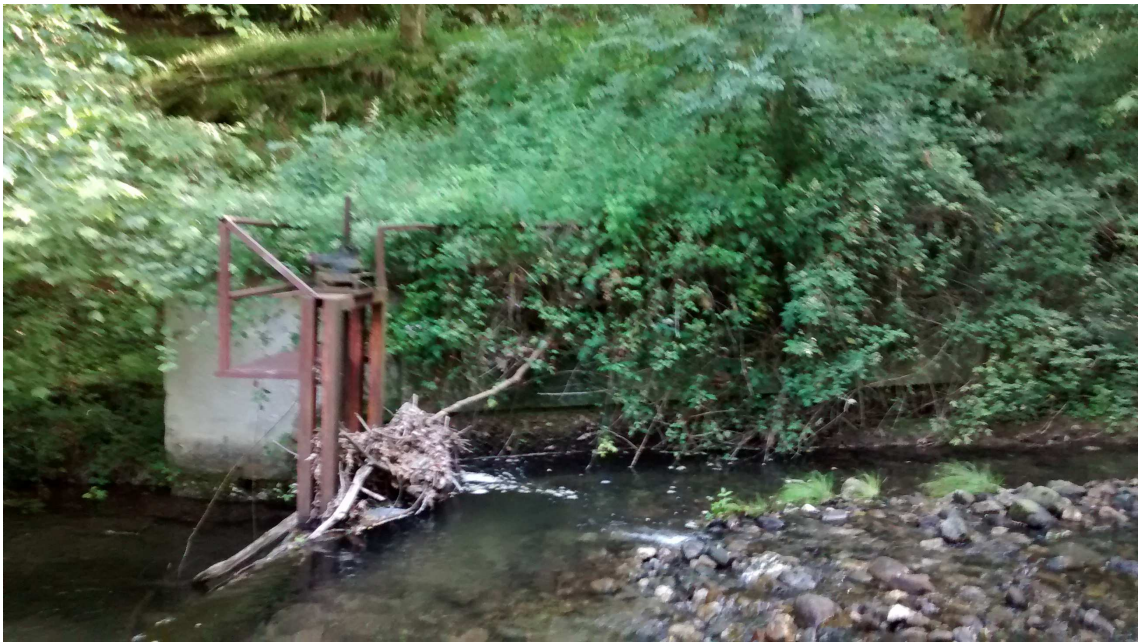
I.5.- EDIFICIO DE TOMA, COMPUERTA Y REJILLAS DE TOMA.
