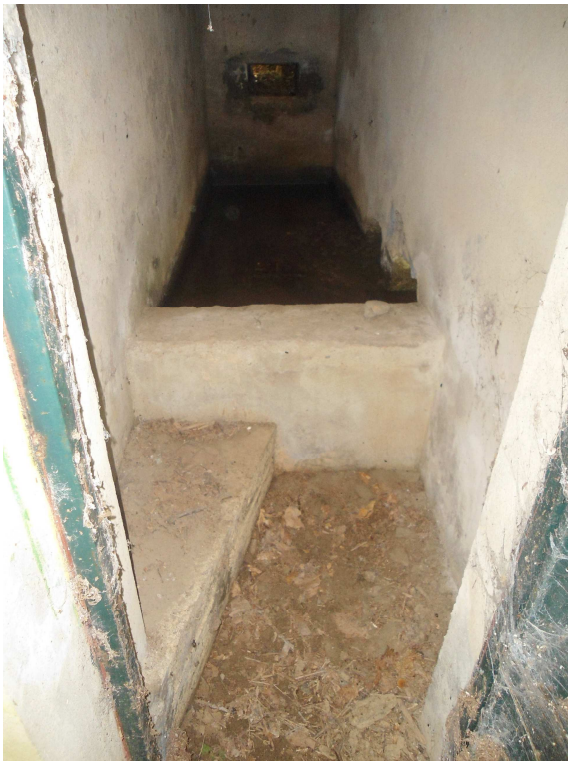
I.9.- INTERIOR DEL EDIFICIO DE TOMA.
