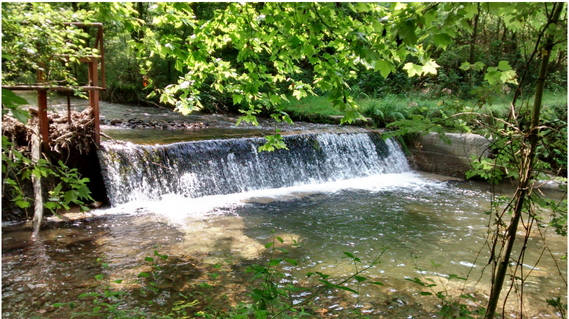
I.4.- VISTA DEL AZUD DESDE ESTRIBO DERECHO AGUAS ABAJO.
