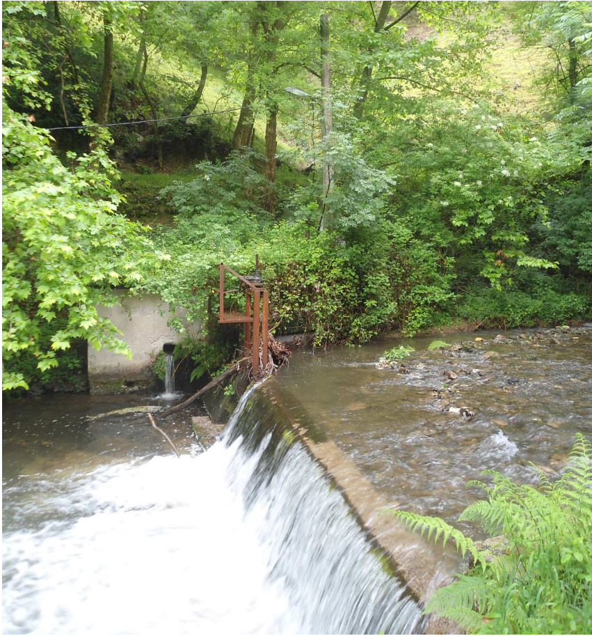
I.1.- VISTA GENERAL DESDE ESTRIBO IZQUIERDO.
