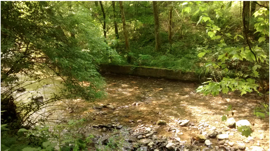
I.8.- MURETE MARGEN IZQUIERDA AGUAS ARRIBA DEL AZUD.
