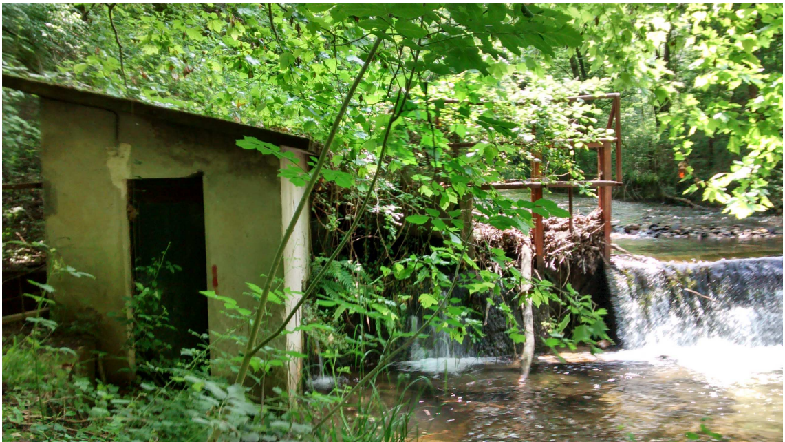
I.3.- EDIFICIO DE TOMA Y COMPUERTA DE LA MARGEN DERECHA.
