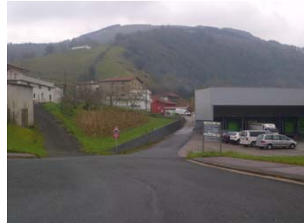
Coexistencia de usos industriales con residenciales en Zubialde
