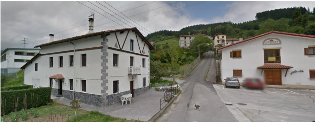
A la izquierda el edificio residencial, en el centro y a mayor cota el barrio de Urtesabel
