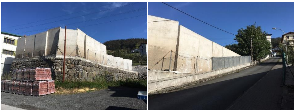
Situación a finales de octubre con las pantallas anti ruido colocadas
