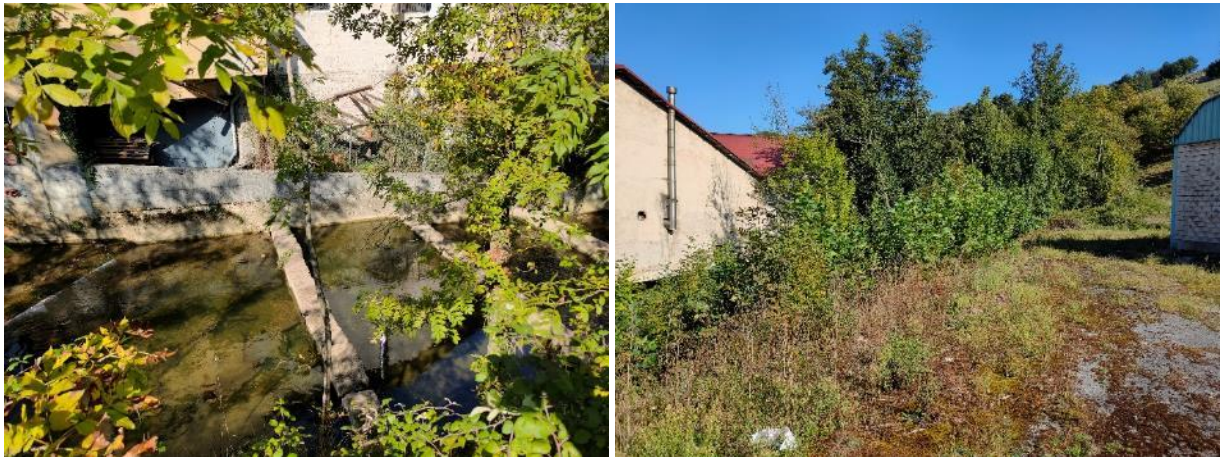
Estructuras en el cauce y ribera repoblada recientemente. Suelos alterados a la altura de Goenaga (nor oeste del sector)
