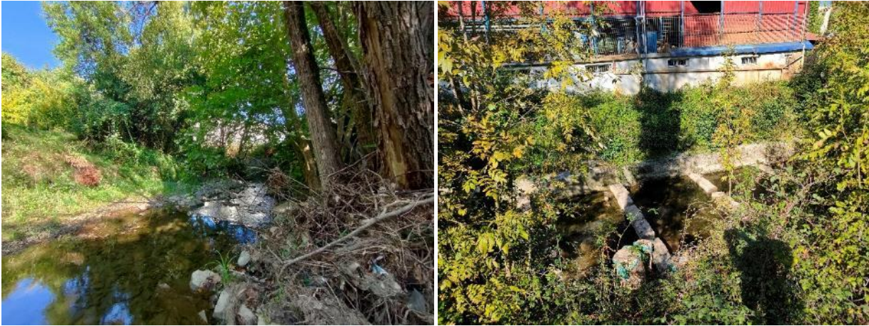
Orilla de la vivienda a la altura del puente de acceso y taludes y estructuras en el cauce al "final" del tramo del río en el sector.
