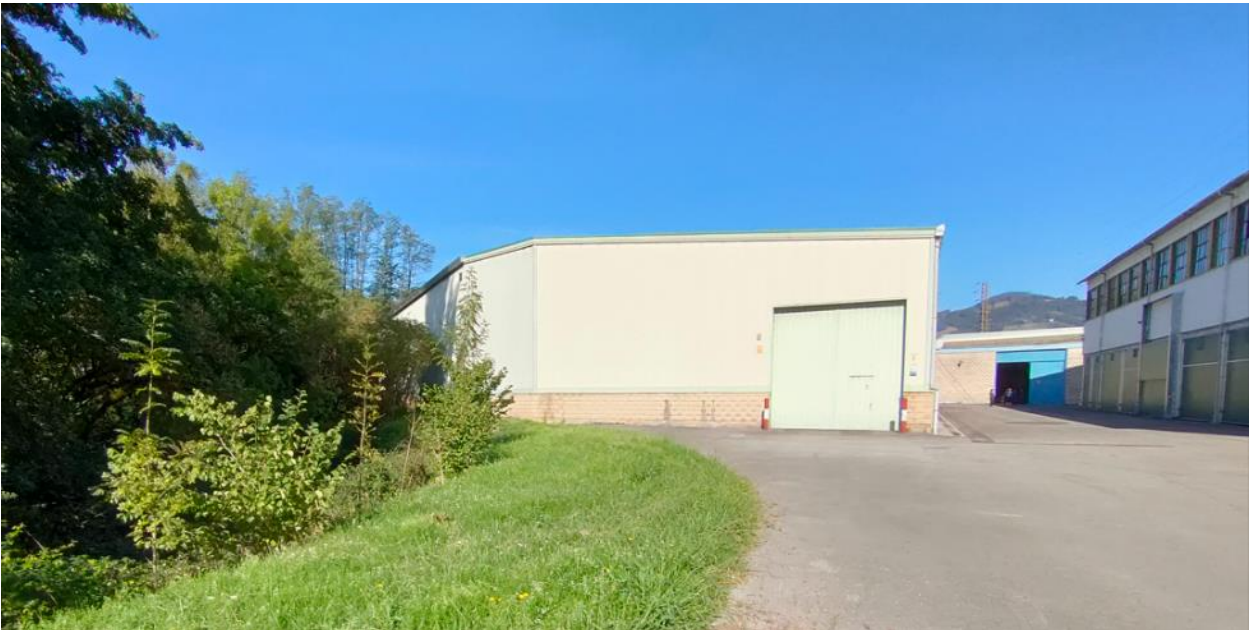
Vista de los pabellones de la zona occidental del sector y de la ribera.
