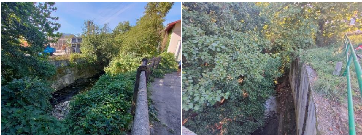
Talud en Bilore y justo antes del puente de acceso al sector
