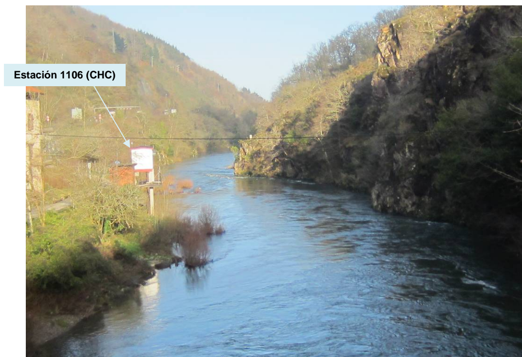
Imagen 1. Vista general de la Estación 1106 desde el puente de Endarlatsa
